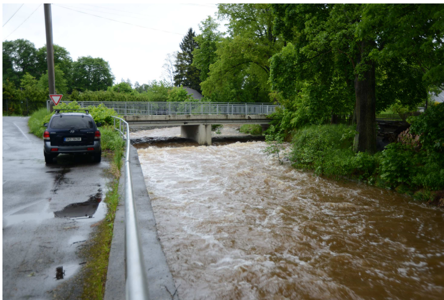
Fotografie [1] – Silniční most ř.km 35.073 ve Strašicích krátce po kulminaci povodně ze dne 2. 6. 2013
