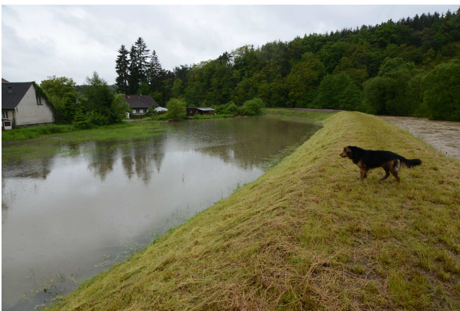
Fotografie [6] – Hladina podél navýšené podélné ochranné hráze u obce Nová Huť v ř.km 7.5 za situace blízko kulminace povodně z 3. 6. 2013
