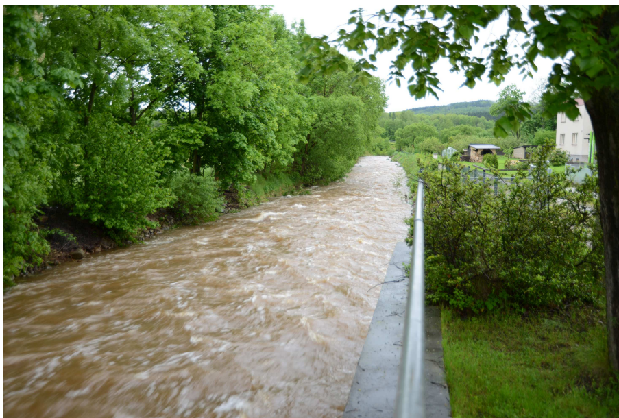
Fotografie [2] – Průběh povodně pod silničním mostem ř.km 35.073 ve Strašicích
