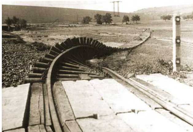
Obr. č. 2 Povodeň 1970 – zcela zdevastovaný úsek železniční trati Čejč – Ždánice u přejezdu silnice Kyjov Brno
