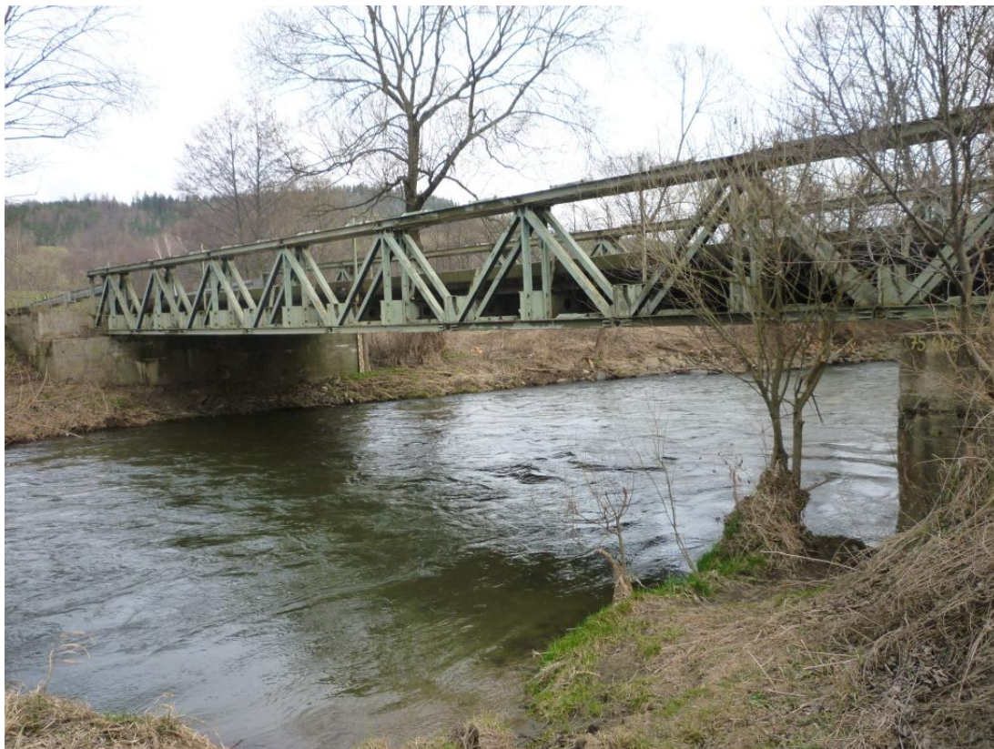
Obrázek 40 – Pohled po proudu na silniční most v Kostelci (TPE 75,40)
