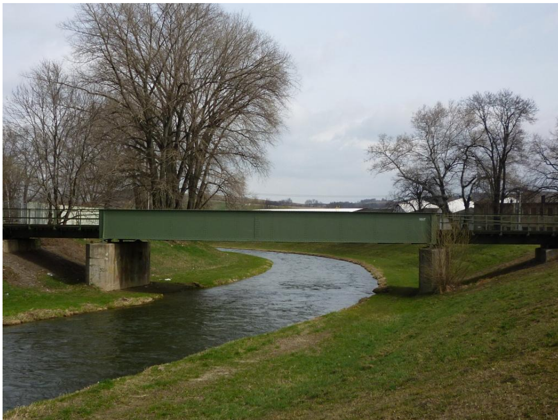
Obrázek 22 – Pohled po proudu na železniční most v Krnově (TPE 69,415)
