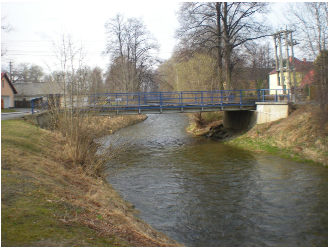
Obrázek 43 – Pohled proti proudu na silniční most u kostela v Branticích (TPE 78,18)
