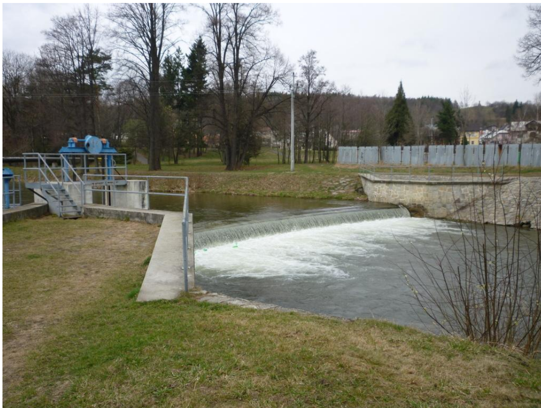
Obrázek 37 – Pohled proti proudu na jezové těleso a odběrný objekt v Kostelci (TPE 72,820)
