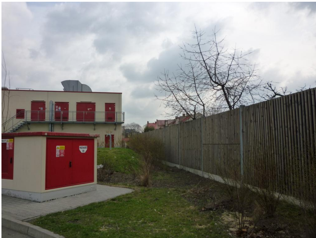
Obrázek 26 – Pohled na plot tvořící překážku proudu, v pozadí obchodní dům Kaufland
