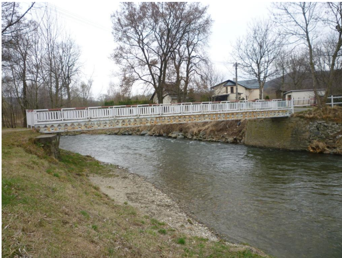
Obrázek 39 – Pohled proti proudu na ocelovou lávku v Kostelci (TPE 73,93)
