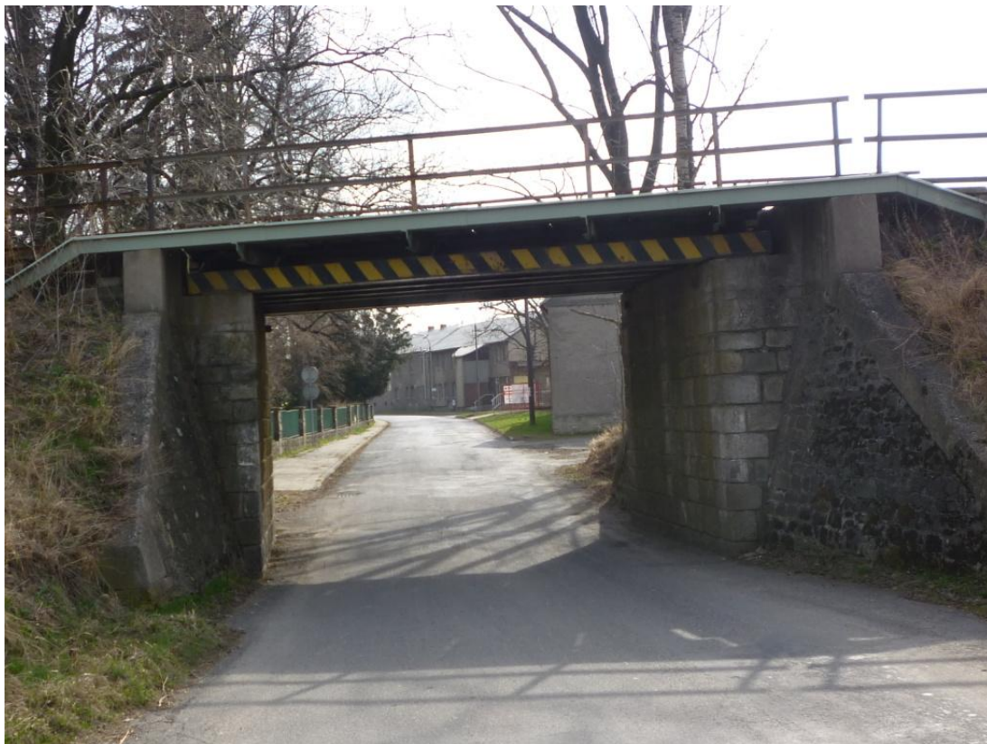
Obrázek 33 – Pohled na podjezd železnice v Krnově, ulice Brantická-Chářovská, významné nátokové okno
