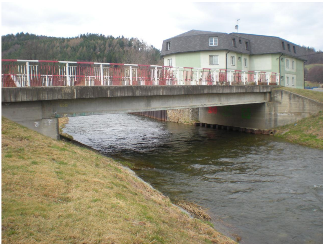
Obrázek 51 – Pohled proti proudu na silniční most v Loučkách u Zátoru (TPE 82,51)
