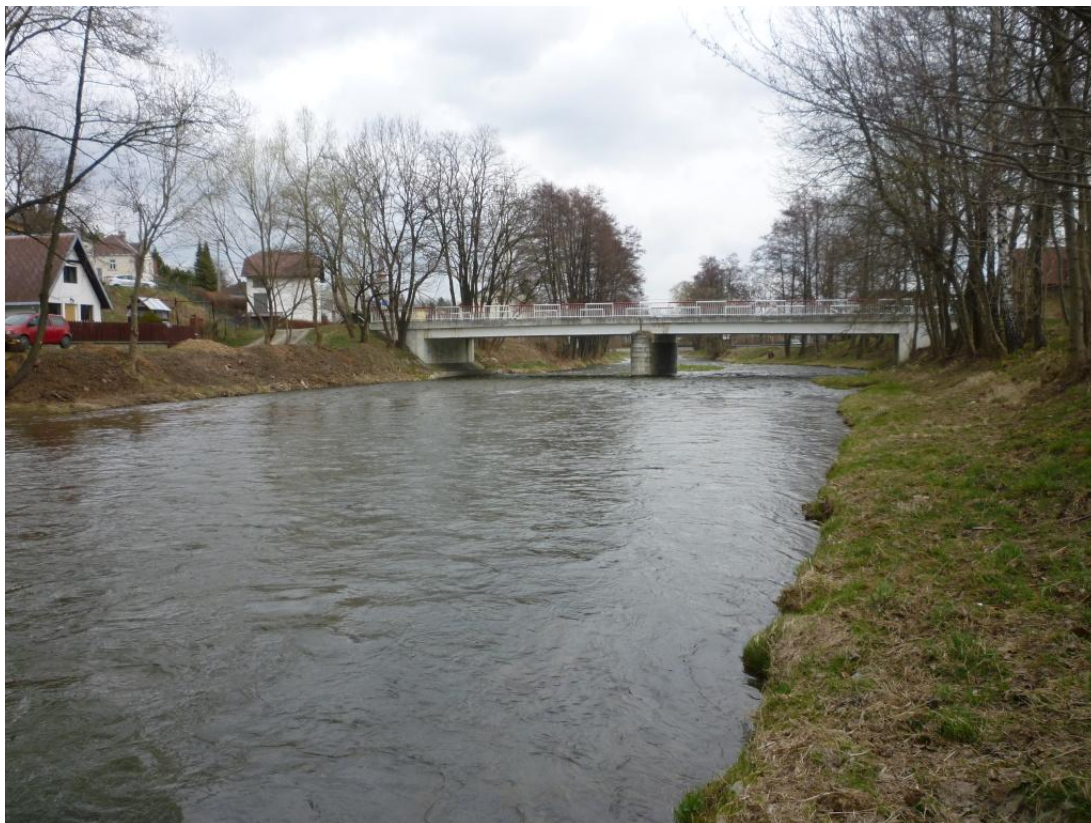
Obrázek 38 – Pohled po proudu na silniční most v Kostelci (TPE 73,51), ulice Mlýnská
