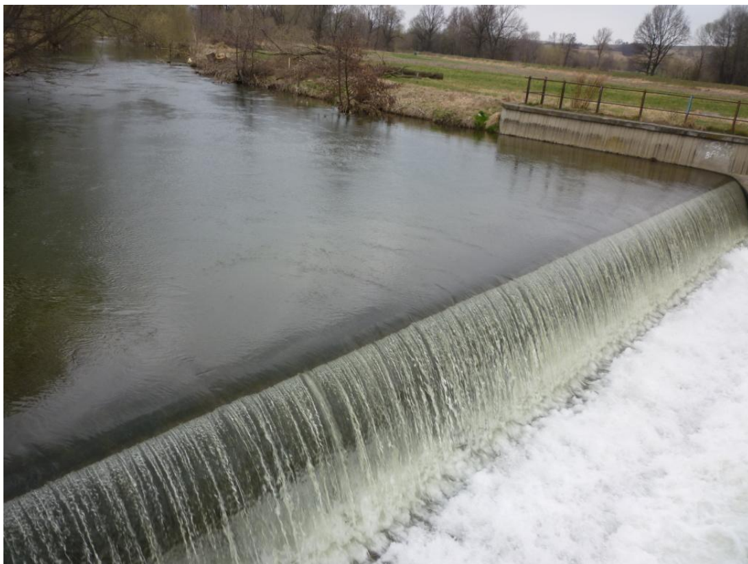
Obrázek 19 – Pohled proti proudu na jezové těleso u ulice Papírový Mlýn (TPE 66,54). V pozadí na pravo polská hráz
