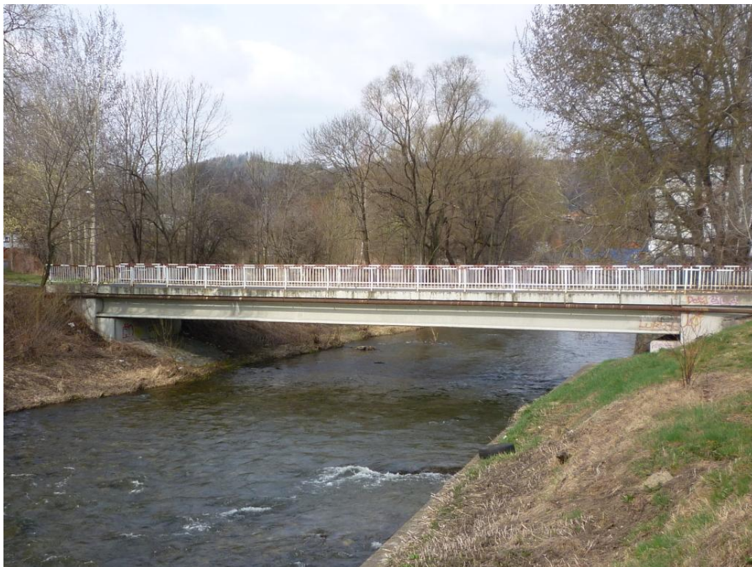
Obrázek 36 – Pohled proti proudu na silniční most v Krnově (TPE 72,37), ulice Na Ostrově
