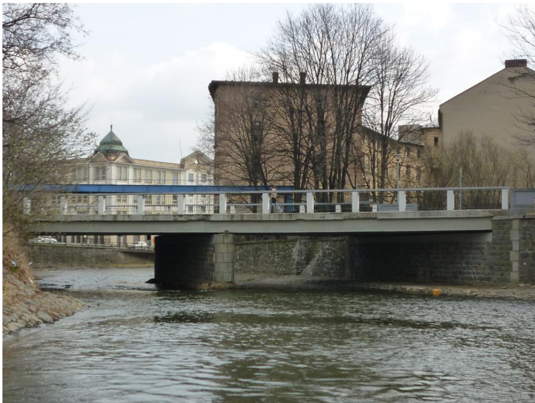
Obrázek 28 – Pohled po proudu na silniční most v Krnově (TPE 70,77), ulice Svatováclavská
