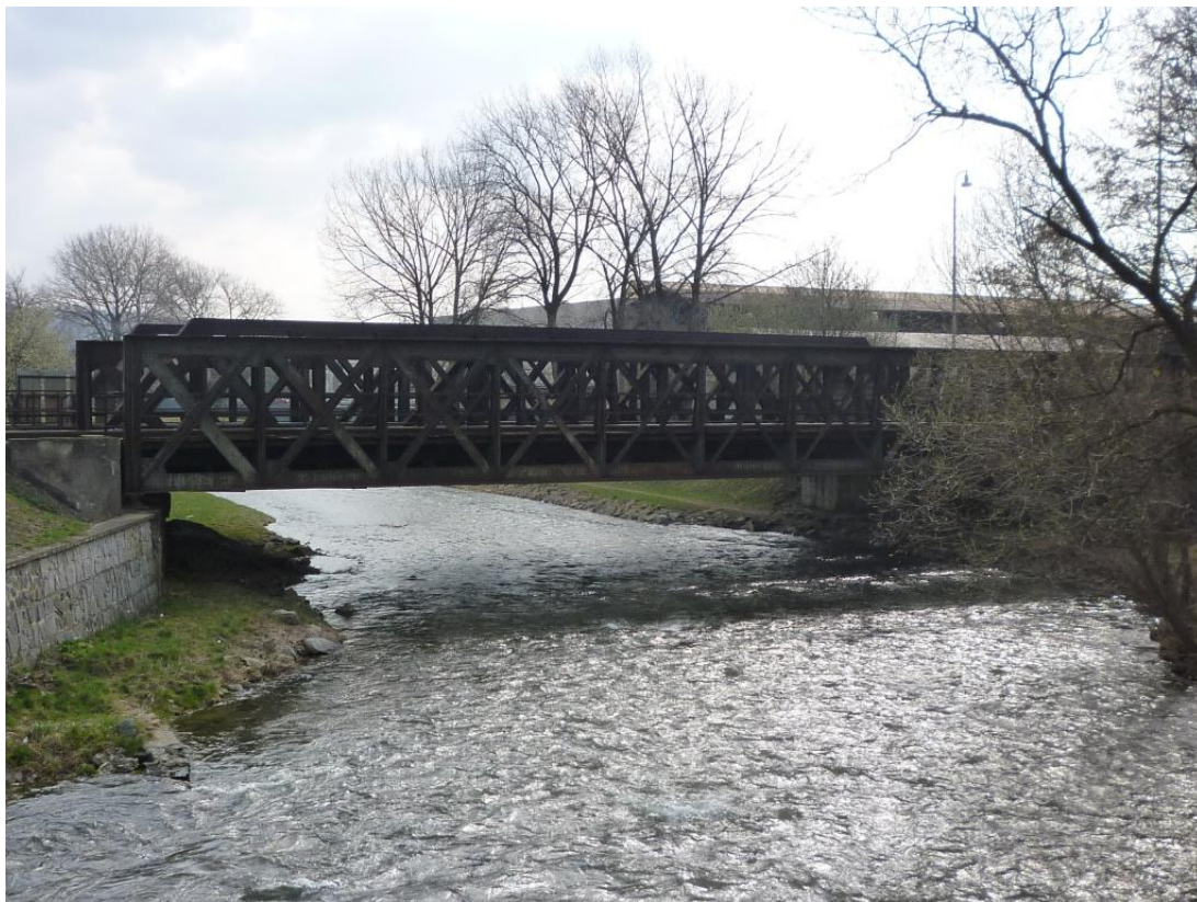
Obrázek 35 – Pohled po proudu na železniční most v Krnově (TPE 72,31)
