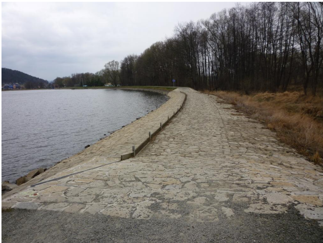
Obrázek 17 – Pohled z koruny hráze Petrova rybníka na bezpečnostní přeliv
