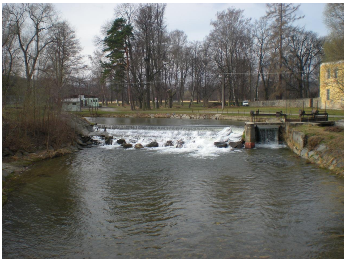
Obrázek 45 – Pohled proti proudu na jezové těleso, štěrkovou propust a náhon, v pozadí zámek Brantice (TPE 78,34)
