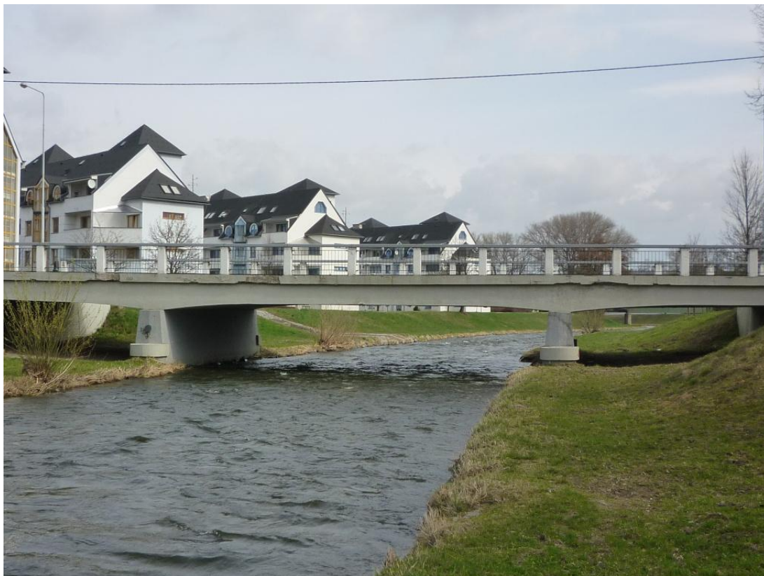
Obrázek 23 – Pohled po proudu na silniční most v Krnově (TPE 69,650), ulice U jatek
