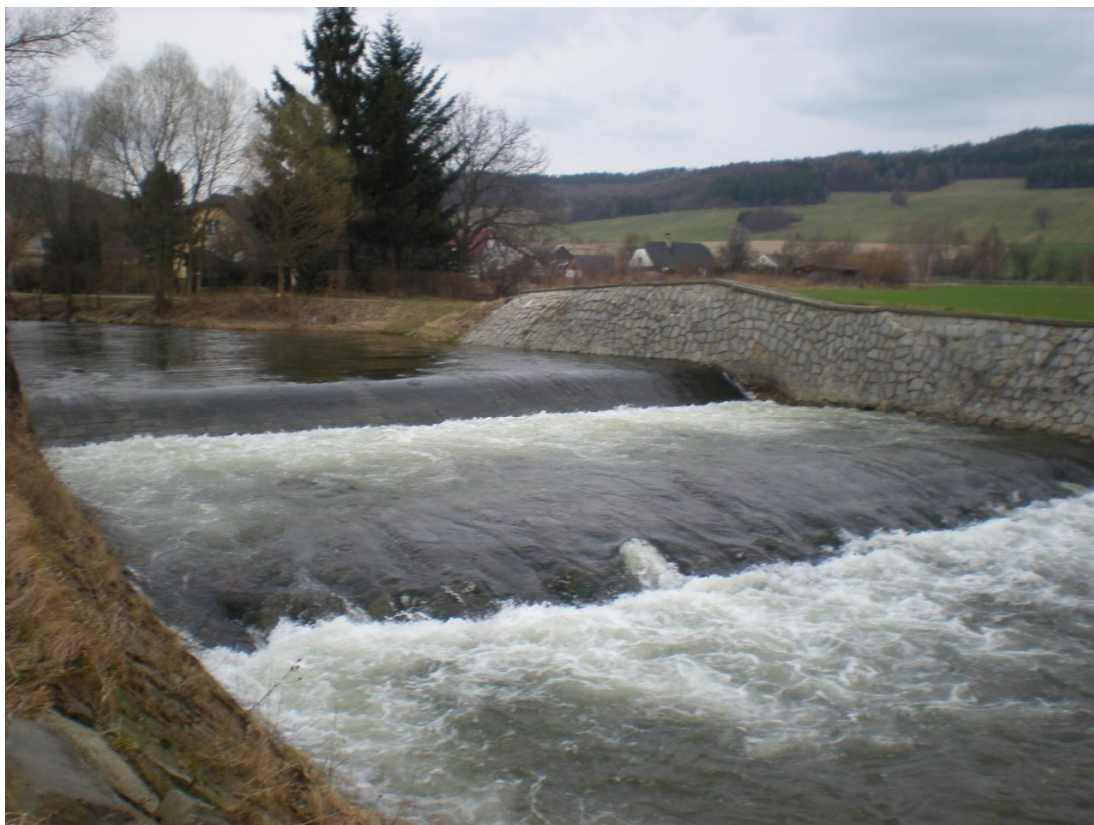
Obrázek 48 – Pohled proti proudu na jezový objekt v Loučkách u Zátoru (TPE 81,10)
