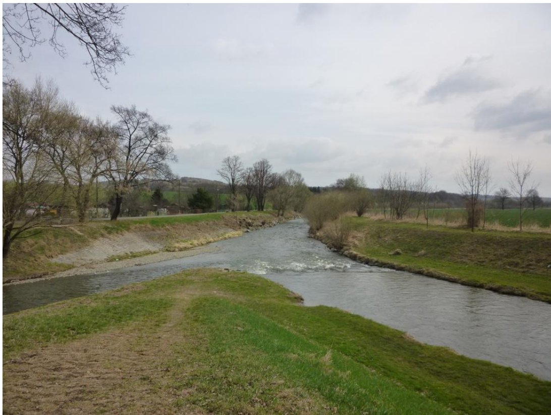
Obrázek 20 – Soutok Opavy a Opavice, pohled po proudu
