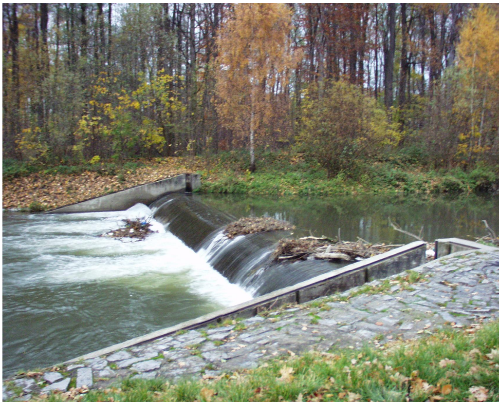
Obrázek 15 – Pohled proti proudu na jezový objekt nad Branícemi (TPE 60,485) [11]
