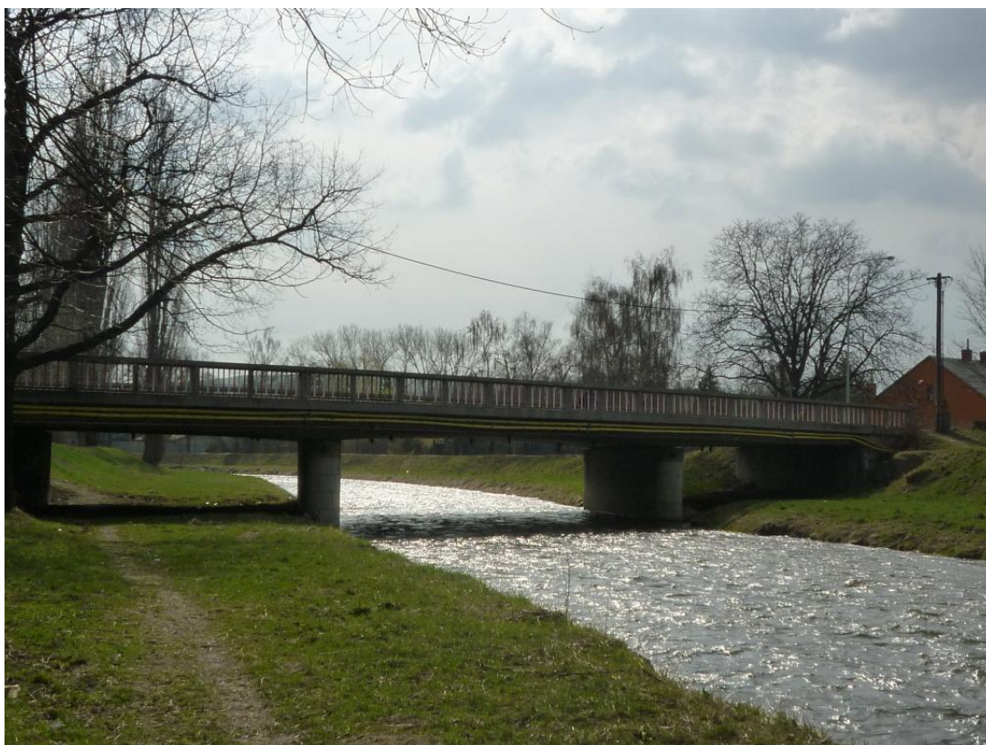
Obrázek 30 – Pohled po proudu na silniční most v Krnově (TPE 71,45), ulice Čsl. armády
