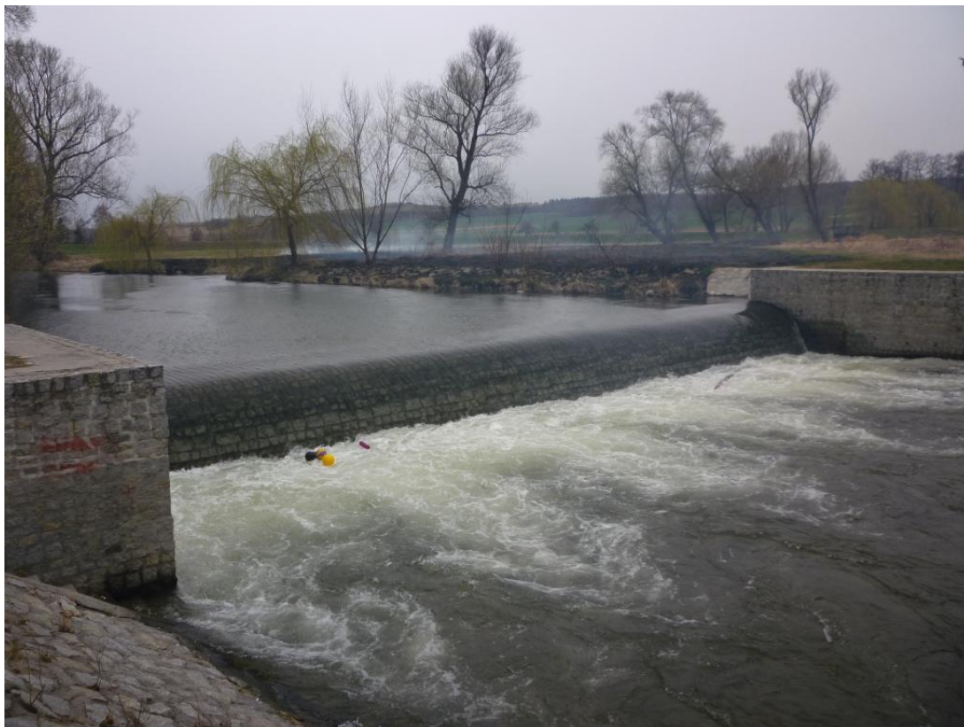
Obrázek 16 – Pohled proti proudu na jezový objekt u Petrova rybníka (TPE 65,464)
