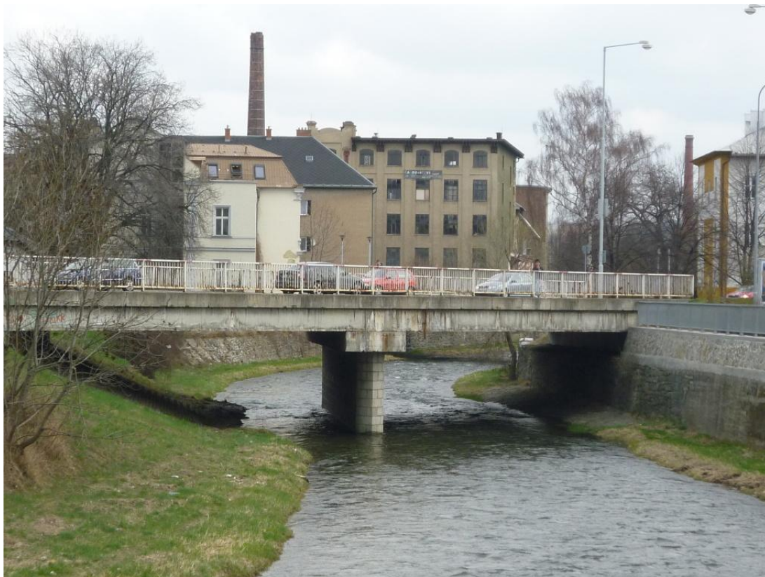
Obrázek 25 – Pohled po proudu na silniční most v Krnově (TPE 70,23), ulice Opavská
