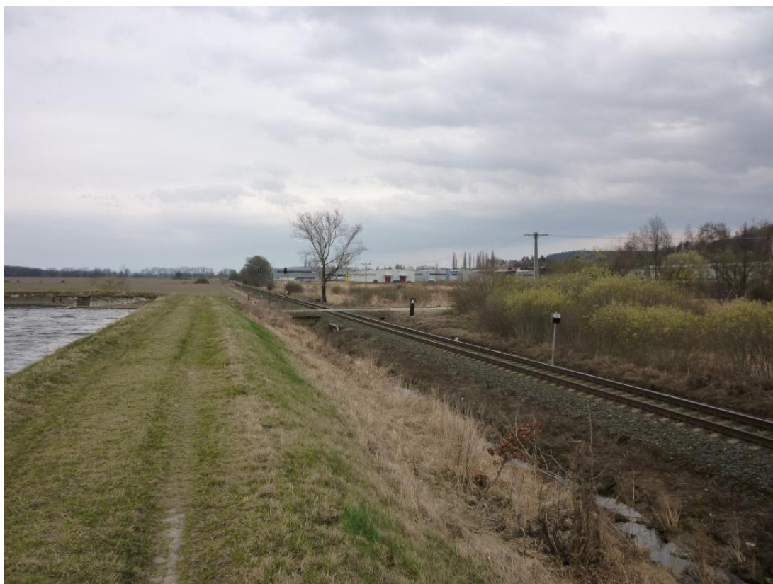
Obrázek 18 – Pohled z pravé hráze Petrova rybníka na železniční trať s příkopy, během větších průtoků tvoří vedlejší proud
