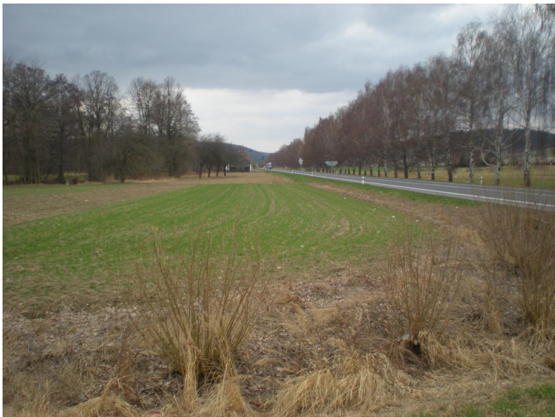
Obrázek 47 – Pohled na silnici I/45 v Branticích z levého břehu u silničního mostu (TPE 80,05). Výšková úroveň komunikace je o něco málo převýšená oproti okolnímu terénu, při Q_{500} byla přelita
