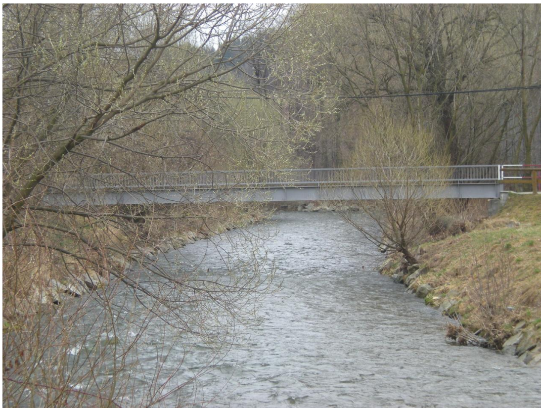
Obrázek 50 – Pohled po proudu na pěší lávku v Loučkách u Zátoru (TPE 82,15)
