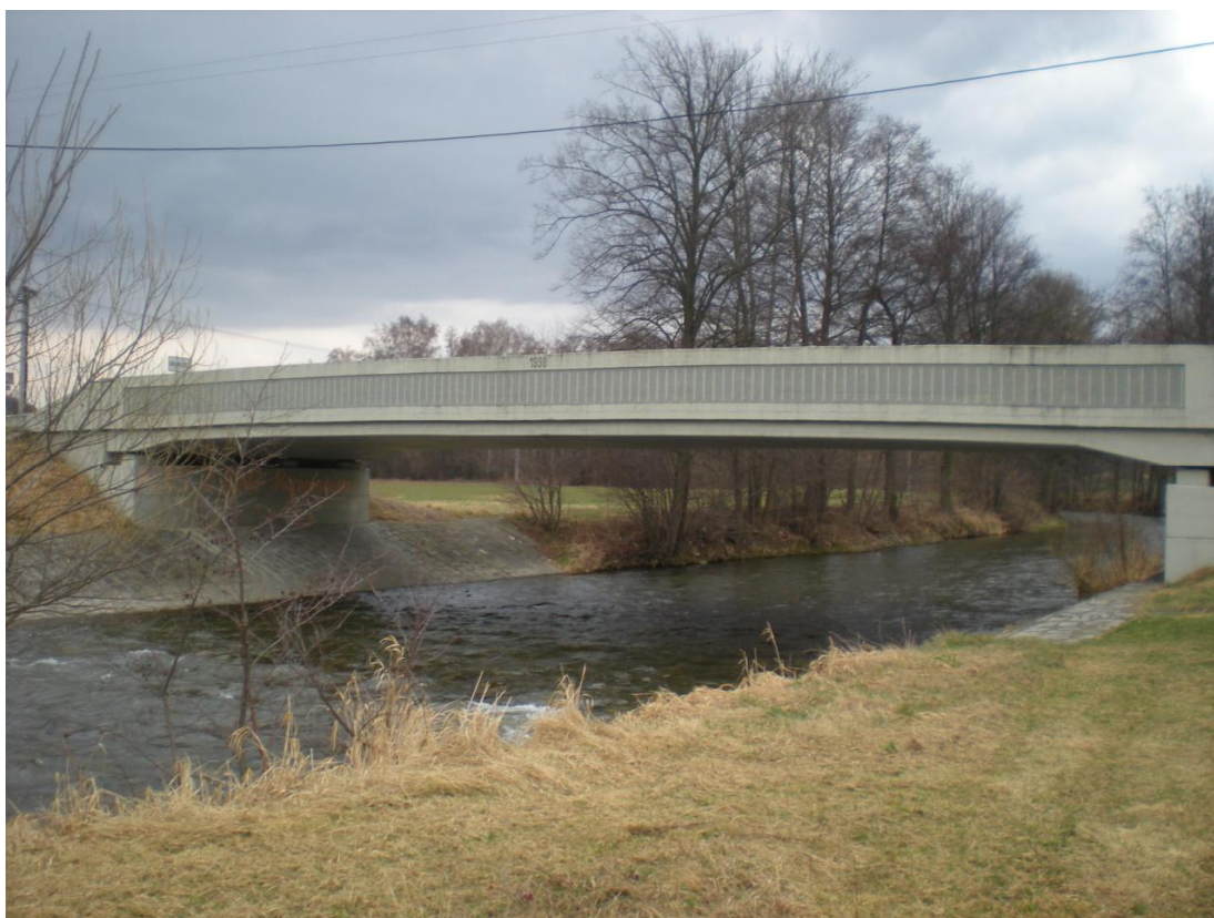
Obrázek 46 – Pohled proti proudu na silniční most v Loučkách (TPE 80,05)
