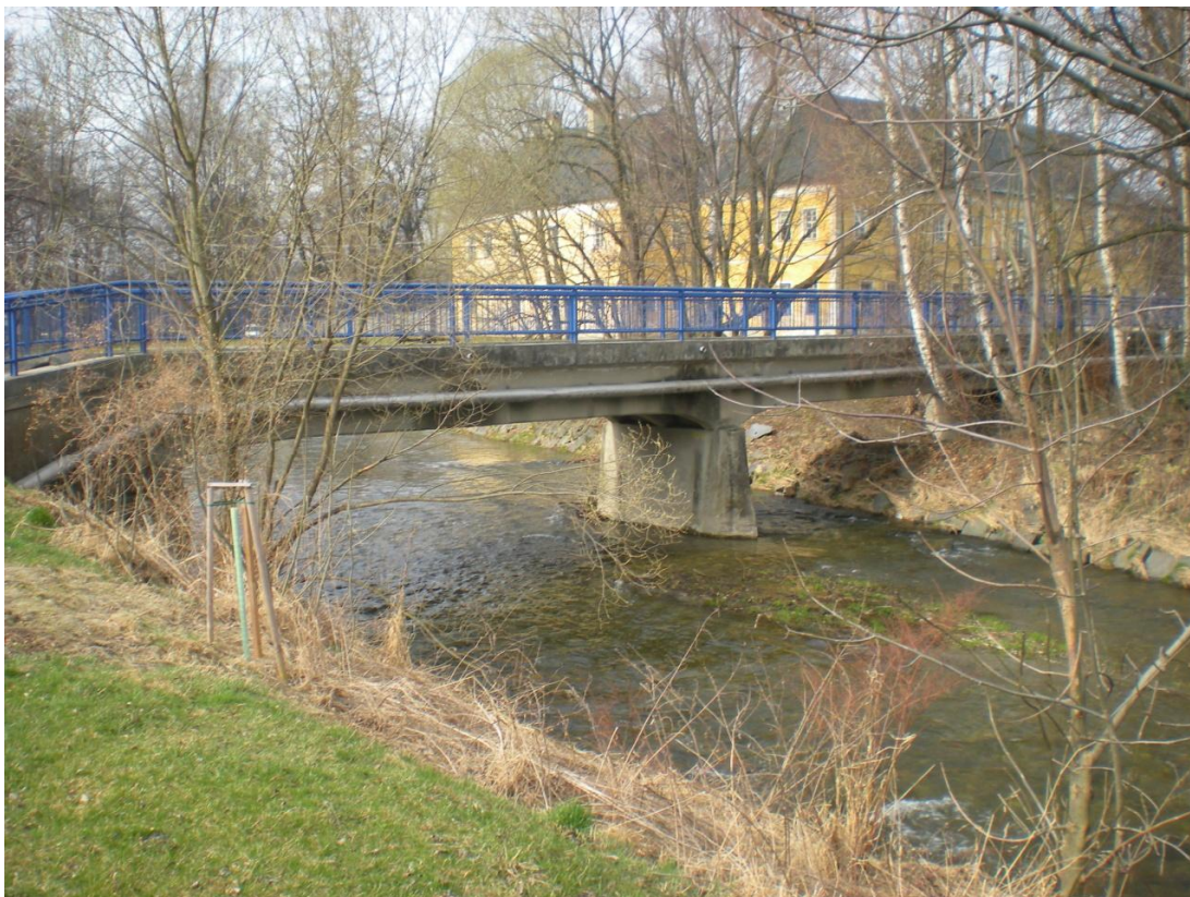
Obrázek 44 – Pohled proti proudu na silniční most v Branticích (TPE 78,29), v pozadí zámek Brantice
