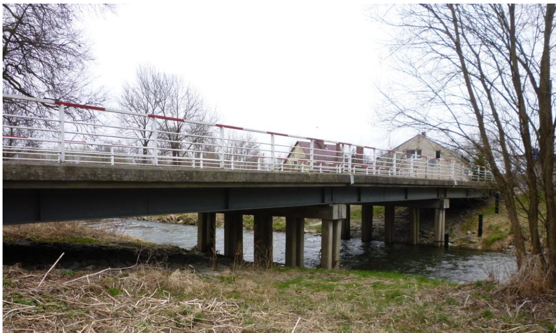
Obrázek 13 – Silniční most v Branici (Úvalno), foceno proti proudu (TPE 58,85)
