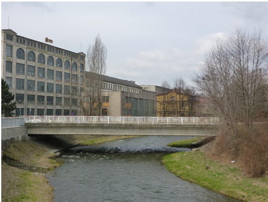
Obrázek 27 – Pohled proti proudu na silniční most v Krnově (TPE 70,35), ulice Sokolovská
