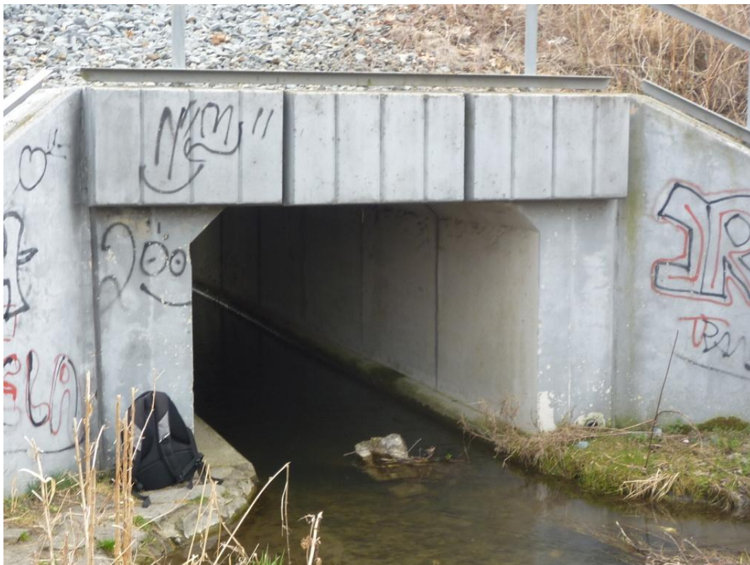
Obrázek 34 – Pohled na propustek převádějící vodu do náhonu Chářovského parku, významné nátokové okno
