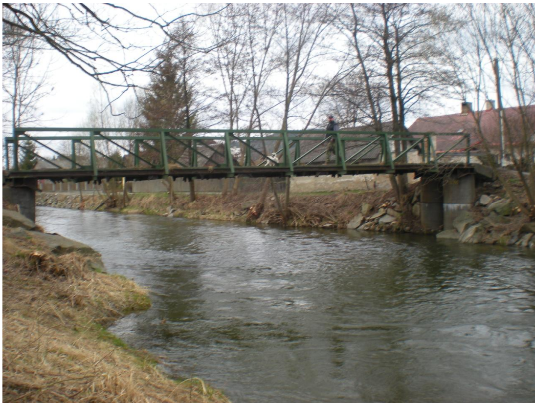
Obrázek 49 – Pohled proti proudu na silniční most v Loučkách u Zátoru (TPE 81,14)
