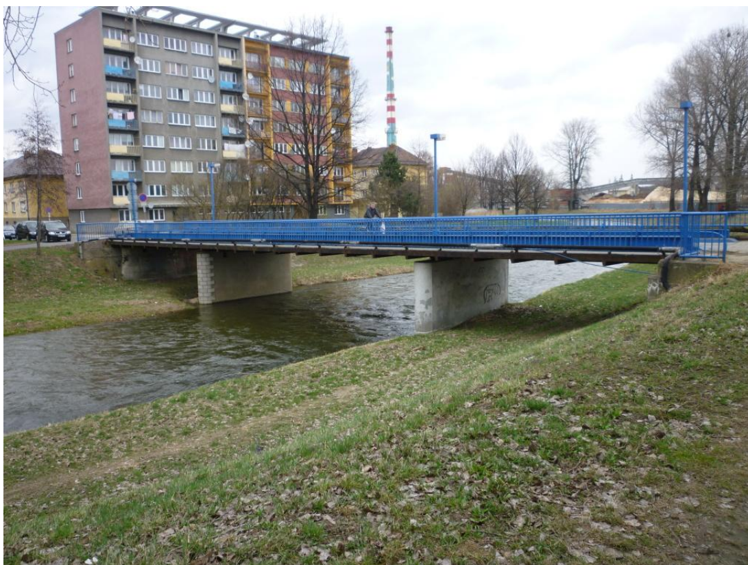
Obrázek 32 – Pohled po proudu na silniční most v Krnově (TPE 72,00), ulice Vrchlického
