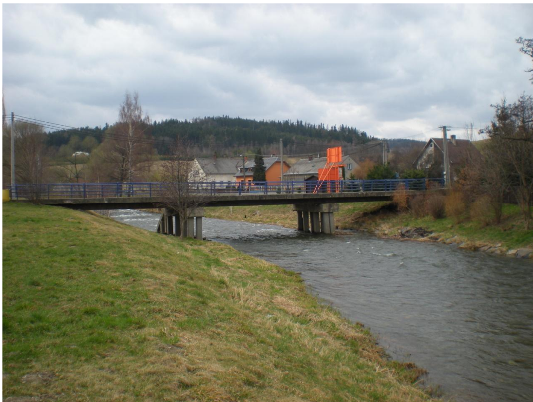
Obrázek 52 – Pohled proti proudu na silniční most v Loučkách u Zátoru (TPE 83,25)
