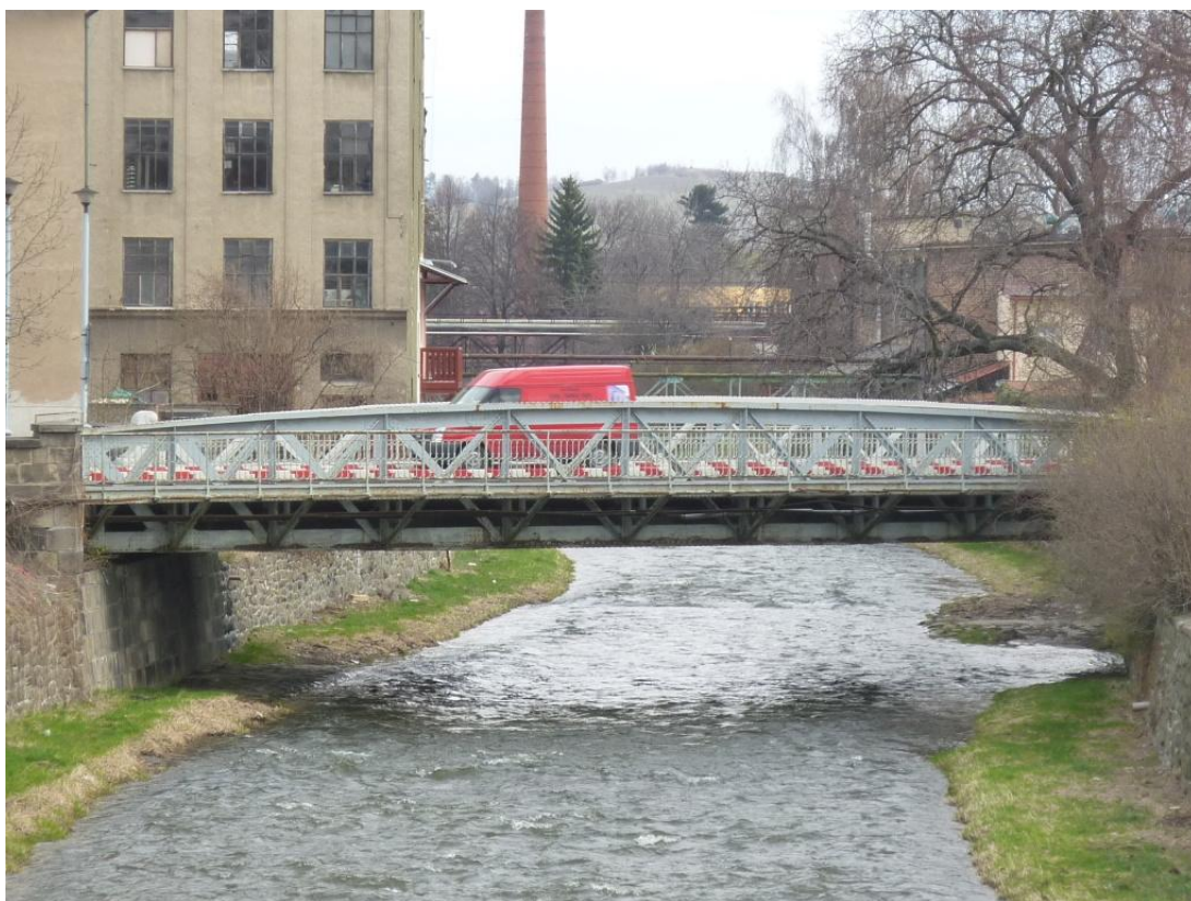
Obrázek 24 – Pohled po proudu na nýtovaný silniční most v Krnově (TPE 70,13), ulice Opavská. Za mostem na pravém břehu je umístěna limnigrafická stanice Krnov
