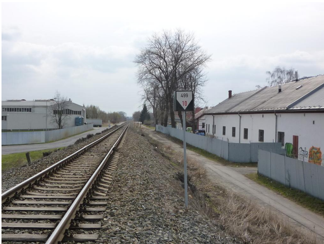
Obrázek 21 – Pohled ze železničního mostu v Krnově směrem k Petrově rybníku. Proud vody je usměrněn podél tělesa
