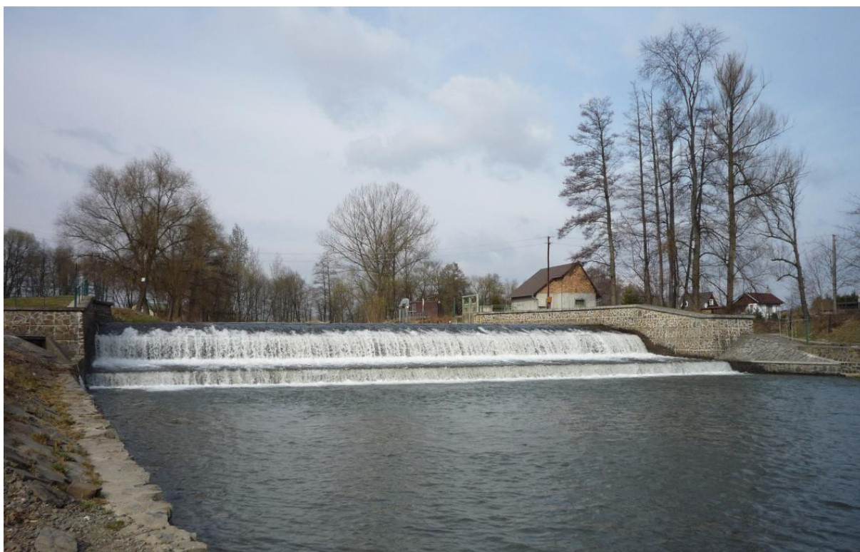
Obrázek 38 – Pohled na jez Opava s tréninkovým kanálem, km 40,000 (TPE 39,490)
