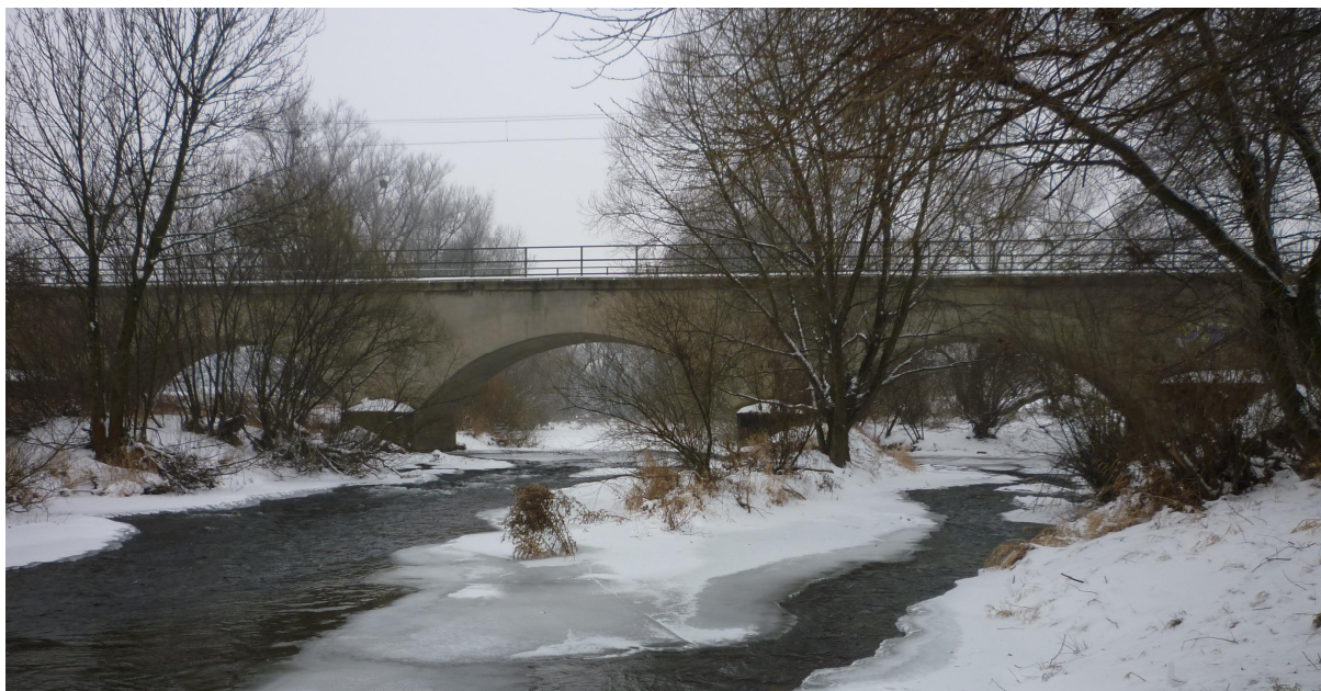
Obrázek 22 – Pohled proti proudu na železniční most přes Moravici, km 1,187
