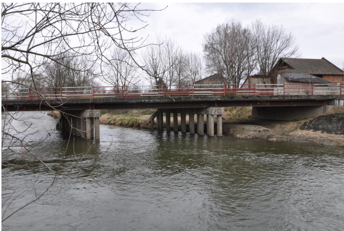
Obrázek 48 – Pohled proti proudu na silniční most v Držkovicích, ul. Polská, km 45,805 (TPE 45,440)
