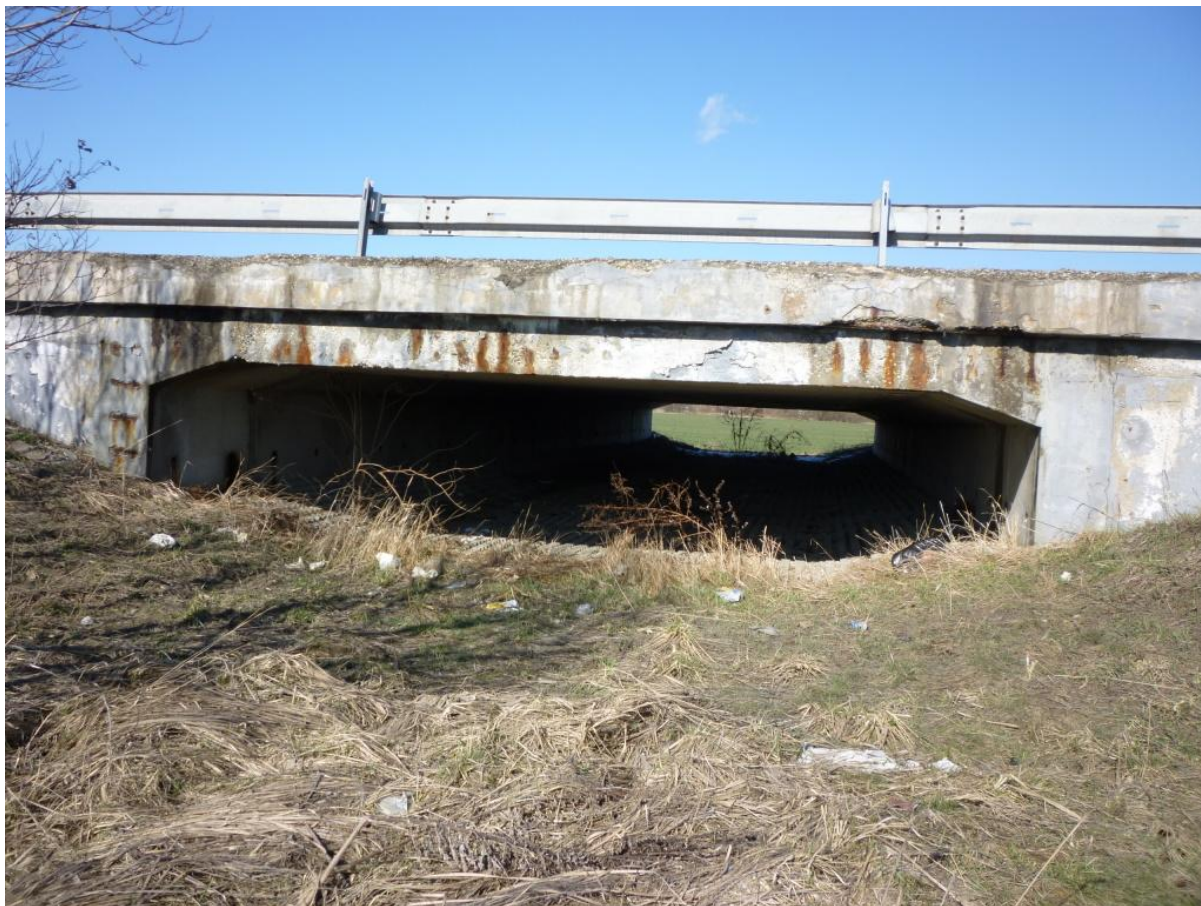
Obrázek 21 – Pohled na jeden ze 3 propustků (šířka 6,0 m; výška 1,4 m) pod sil. I/11, Moravice km 0,599
