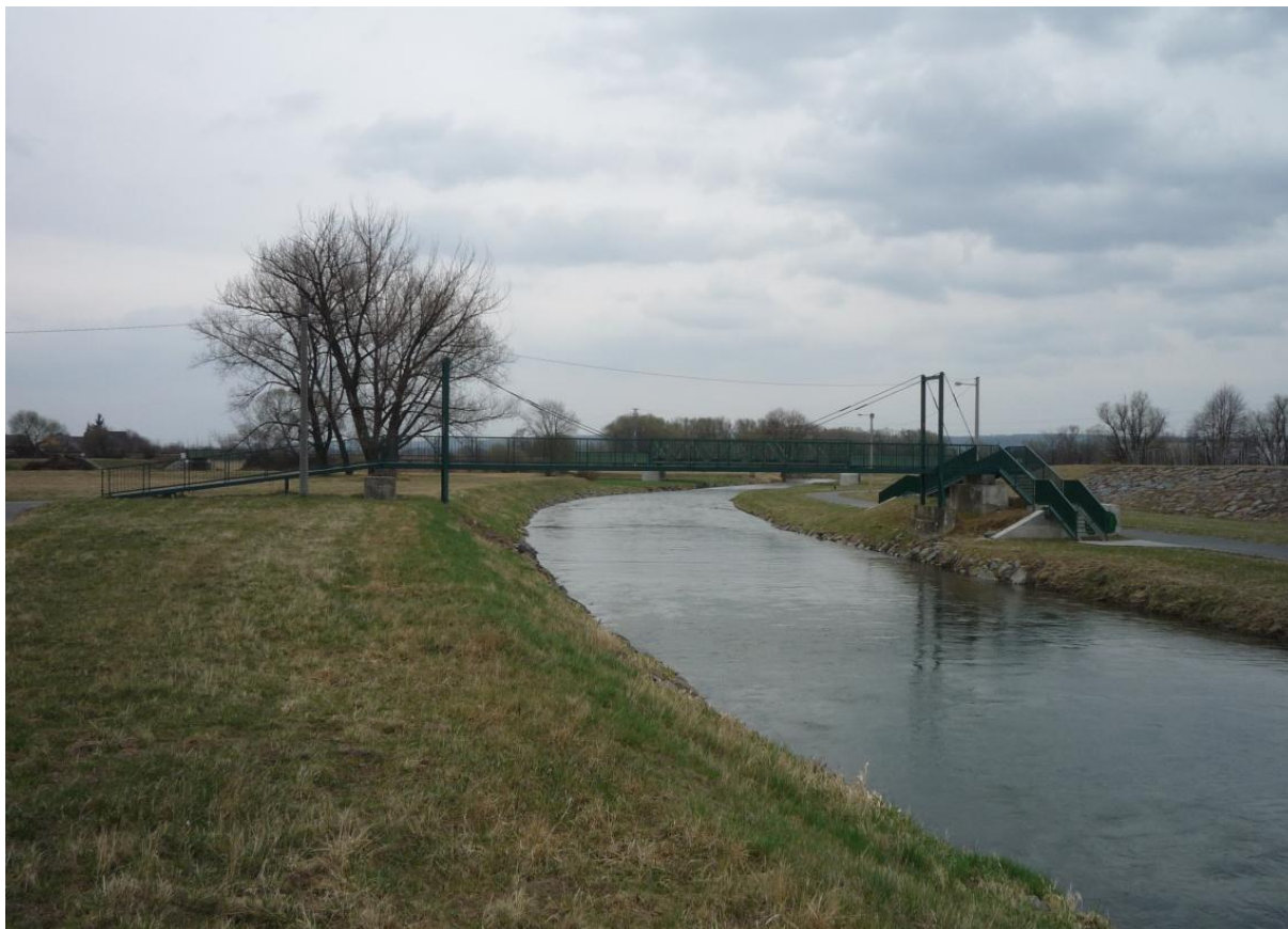
Obrázek 25 – Ocelová lávka pro pěší, pohled po proudu, km 34,560 (TPE 34,080)
