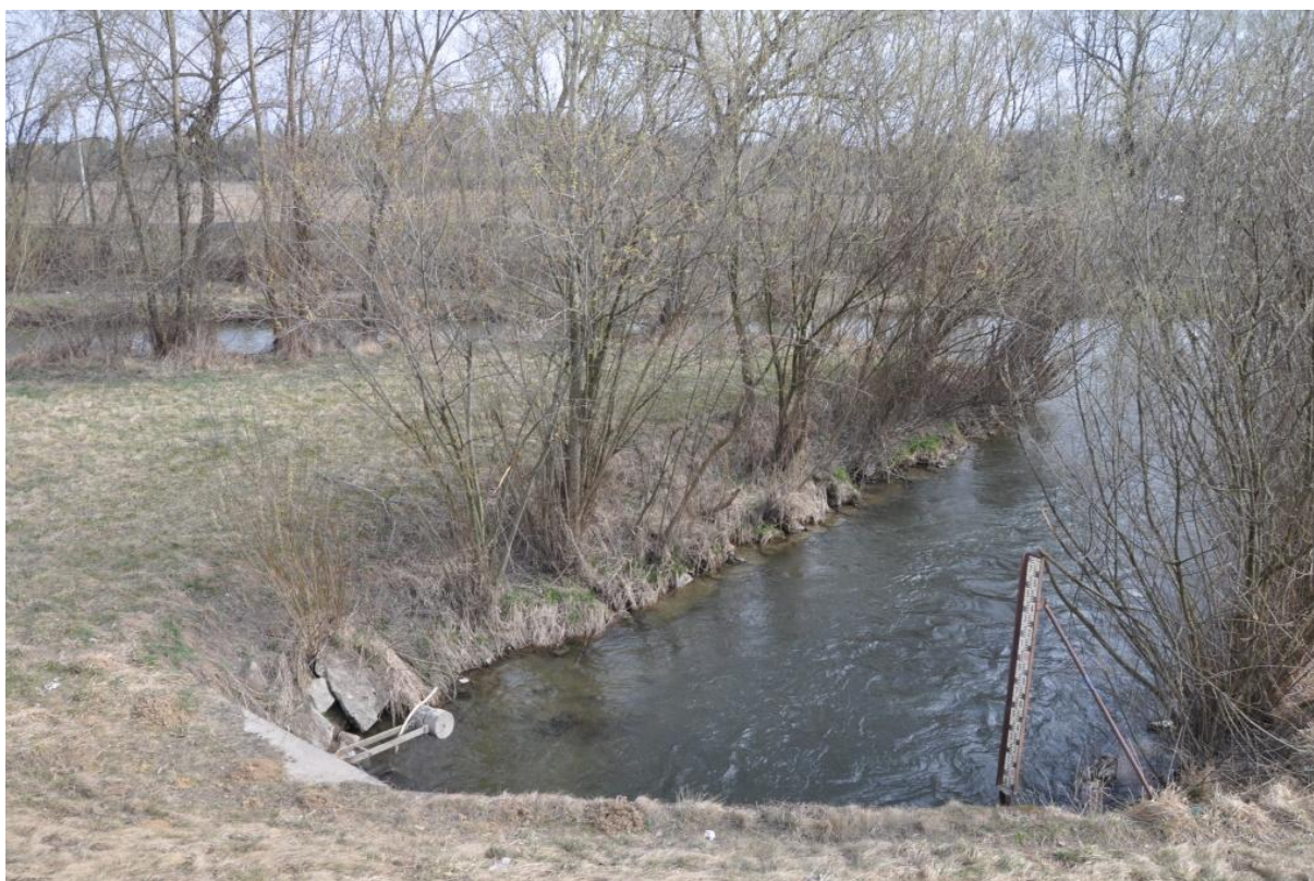
Obrázek 40 – Pravobřežní vyústění Mlýnského náhonu zpět do Opavy, km 70,710
