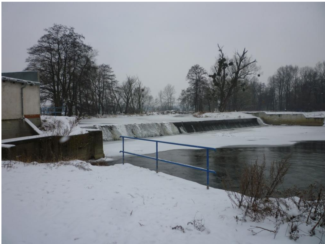
Obrázek 15 – Pohled na jez Kravaře s MVE na PB, km 28,930 (TPE 28,450)
