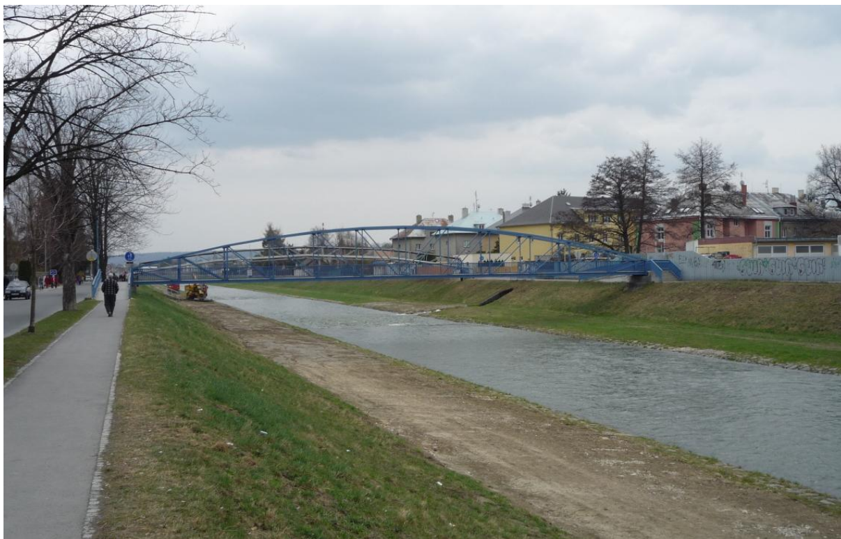
Obrázek 28 – Pohled po proudu na ocelovou lávku pro pěší, Kolofíkovo nábřeží km 36,212 (TPE 35,730)
