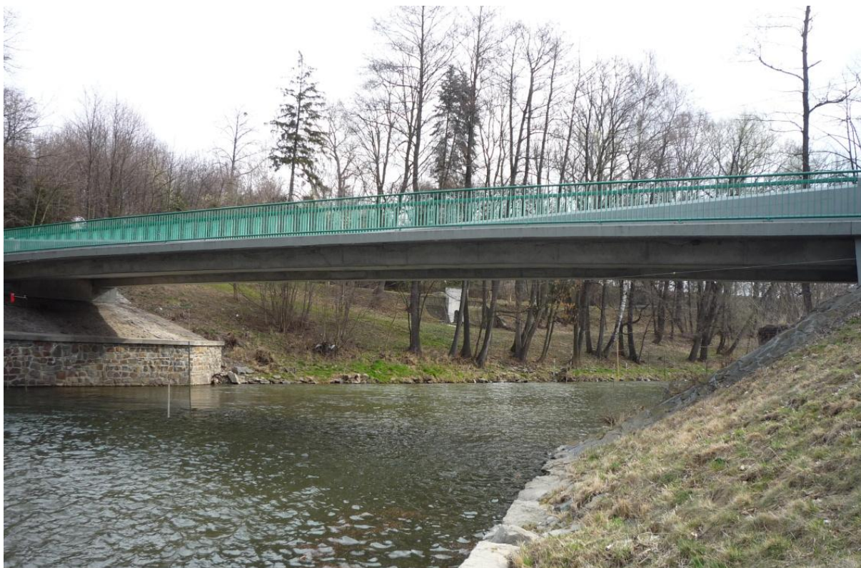
Obrázek 37 – Pohled na silniční most na ul. Jaselská po proudu, km 39,908 (TPE 39,400)
