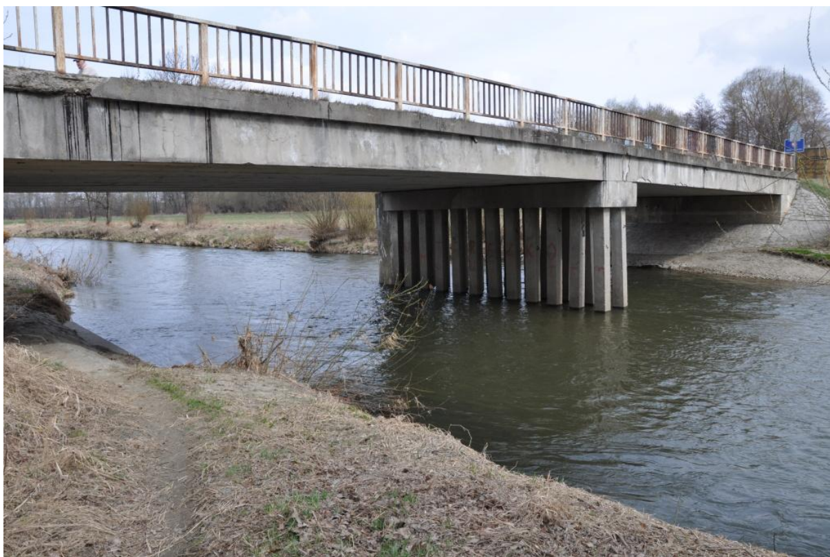
Obrázek 46 – Pohled proti proudu na silniční most, ul. K Celnici, Vávrovice, km 43,528 (TPE 43,190)
