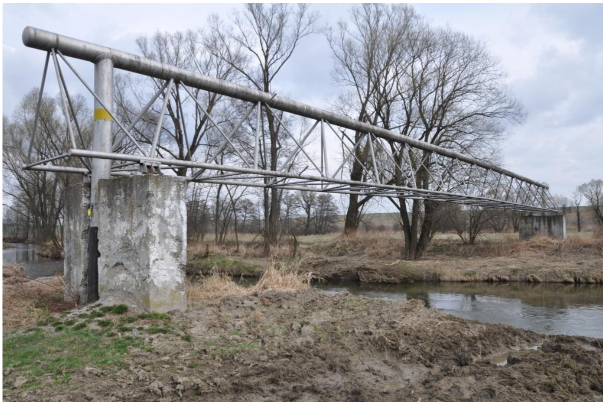
Obrázek 45 – Most plynového potrubí, pohled proti proudu, km 42,181 (TPE 41,545)
