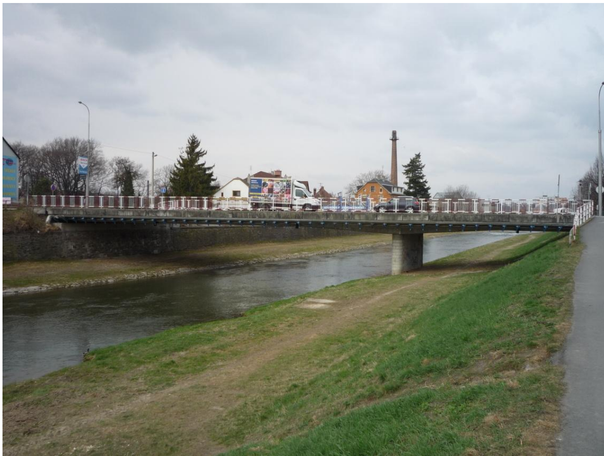
Obrázek 31 – Pohled na silniční most ul. Pekařská, proti proudu km 37,744 (TPE 37,250)
