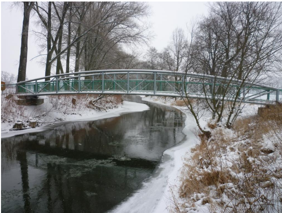
Obrázek 13 – Ocelový most pro pěší, pohled po proudu, km 24,733 (TPE 24,285)
