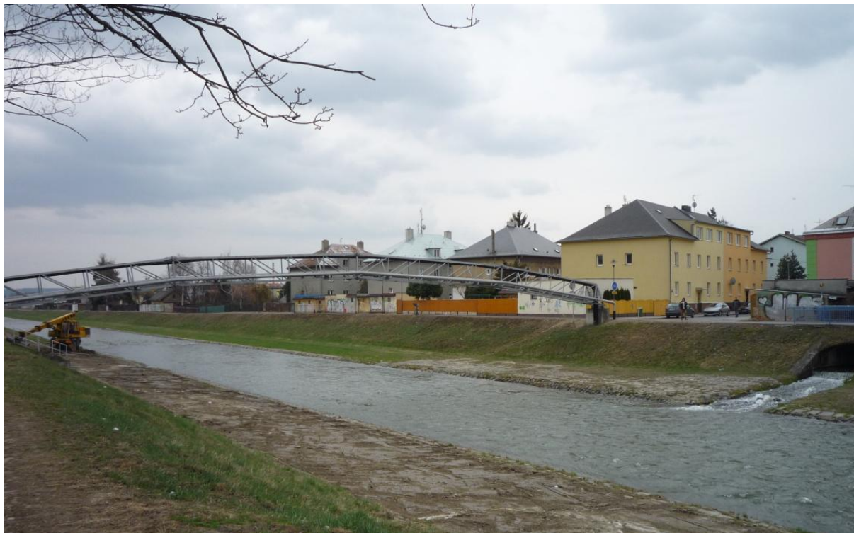
Obrázek 27 – Pohled po proudu na potrubní most plynovodu a pravobřežní výust Městského náhonu, ul. Mlýnská, km 36,152 (TPE 35,675)
