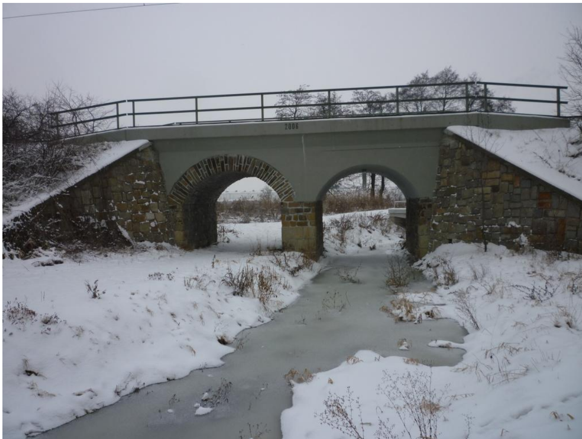
Obrázek 23 – Pohled na železniční most v levé inundaci Moravice, tvoří významné natokové okno, km 1,187
