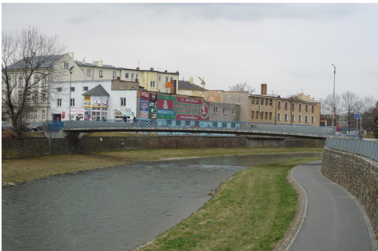
Obrázek 30 – Pohled na pěší lávku ul. Vodní, proti proudu 37,203 (TPE 36,740)
