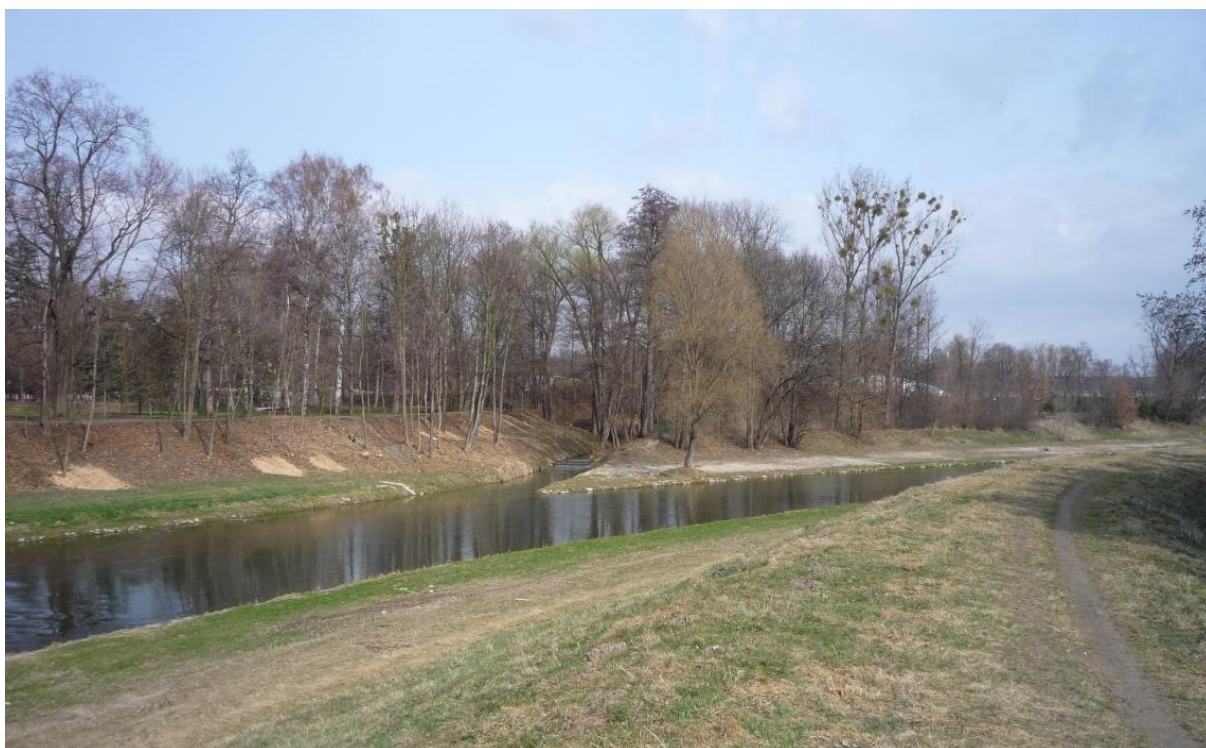
Obrázek 34 – Pohled proti proudu na pravobřežní přítok toku Velká, km 39,276
