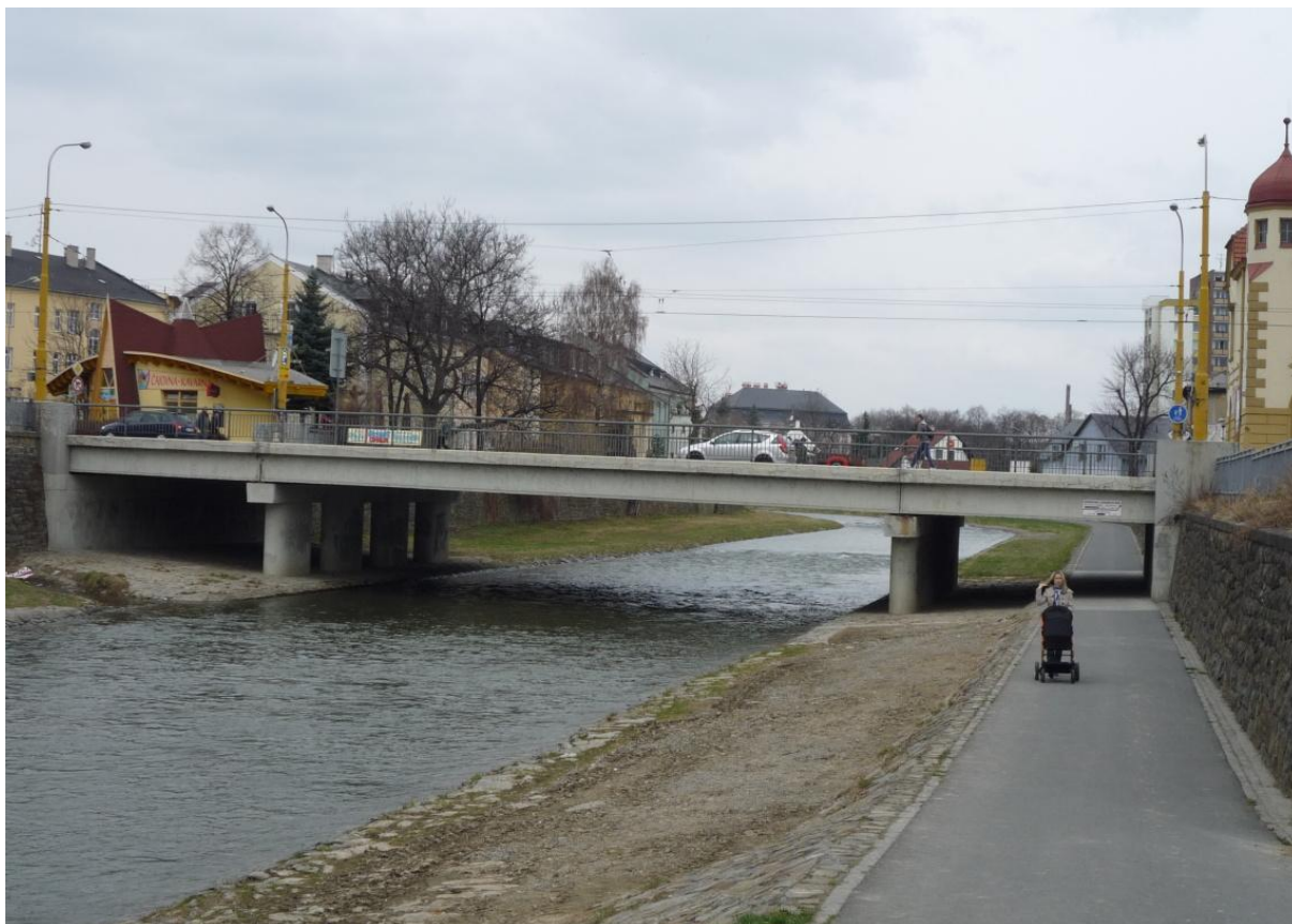
Obrázek 29 – Pohled na silniční most ul. Ratibořská, proti proudu km 36,960 (TPE 36,480)
