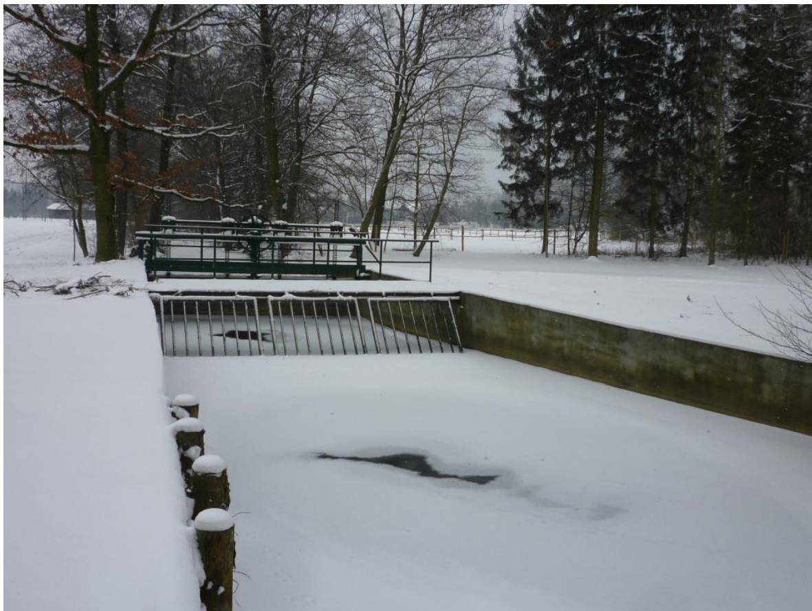
Obrázek 12 – Nátokový objekt do mlýnského náhonu na PB, km 22,450
