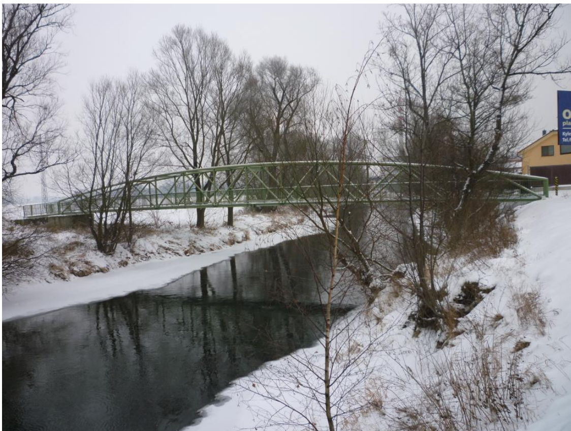
Obrázek 16 – Pohled po proudu na ocelovou lávku pro pěší, km 32,079 (TPE 31,580)
