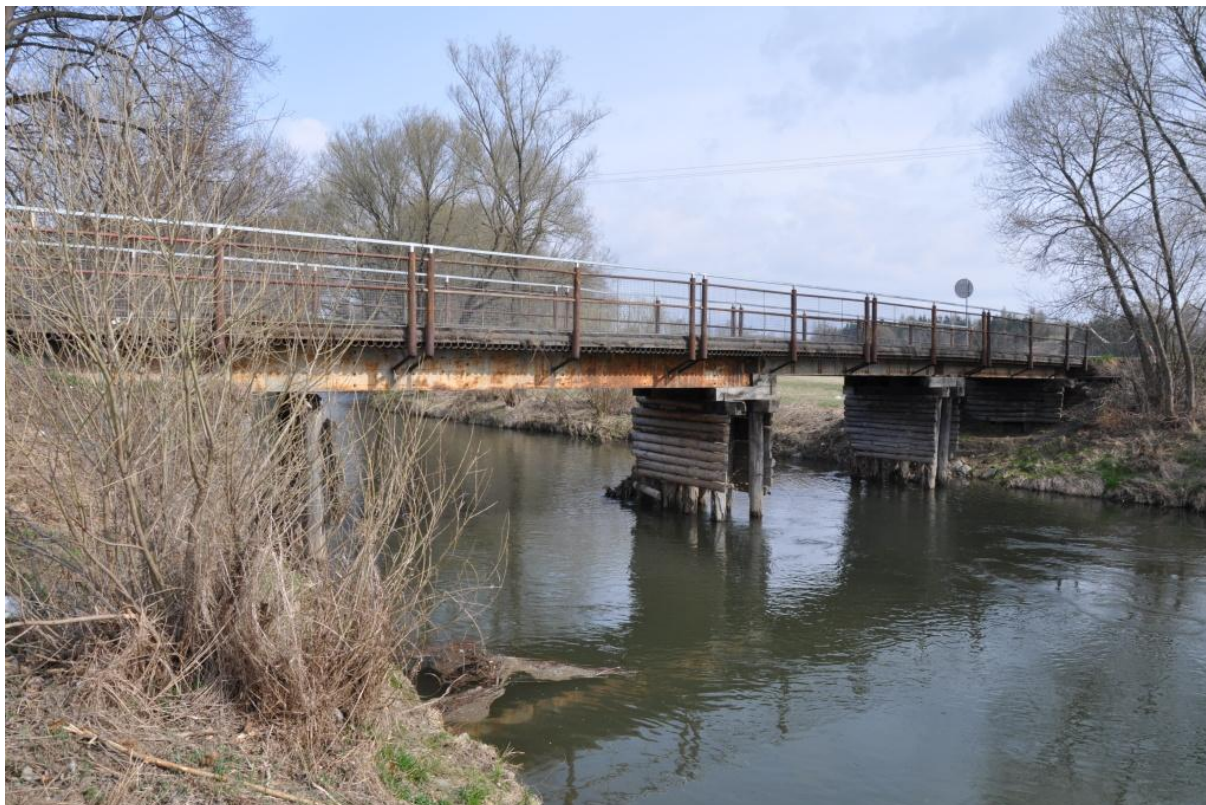
Obrázek 41 – Pohled na most na ul. U Lávky, km 40,932 (TPE 40,420)
