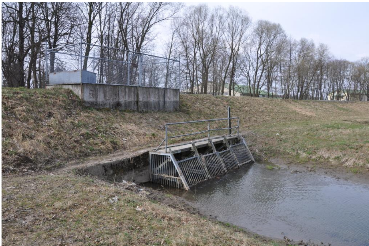
Obrázek 39 – Nátokový objekt do Městského náhonu na PB, km 40,190
