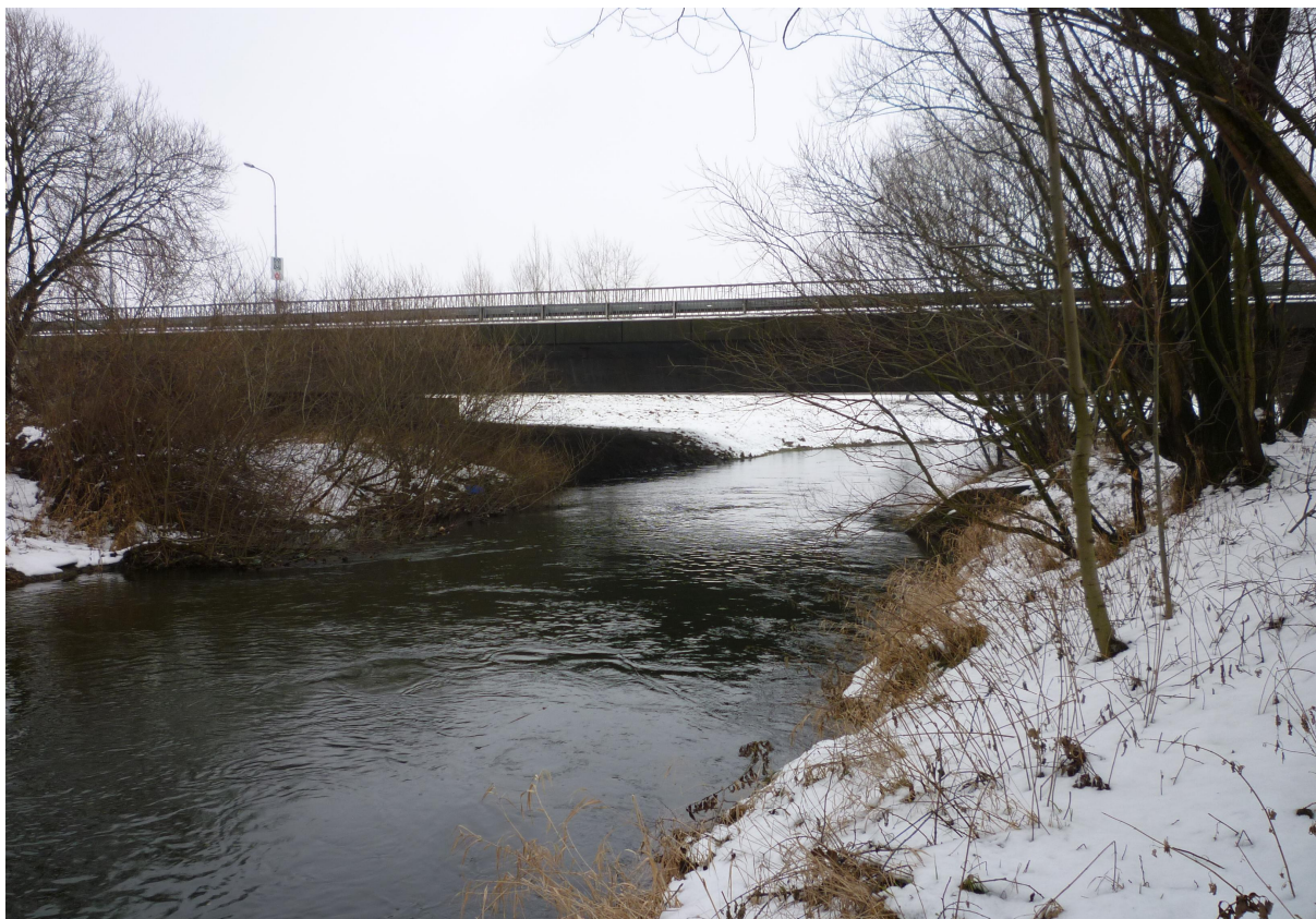
Obrázek 20 – Pohled na silniční most přes Moravici, ul.Ostravská, sil. I/11, km 0,599
