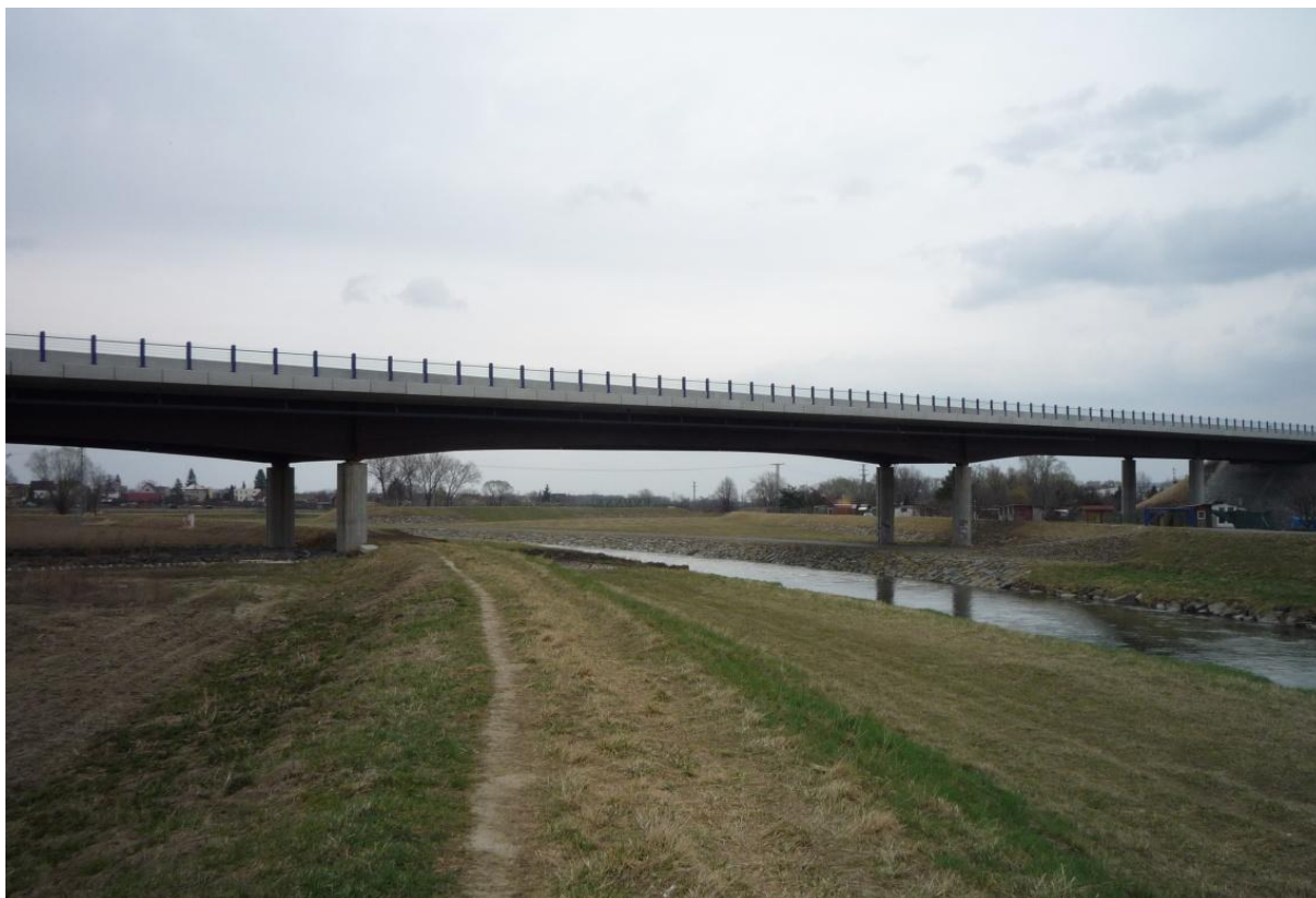
Obrázek 26 – Pohled na silniční most silnice S11 po proudu, km 34,800 (TPE 34,400)
