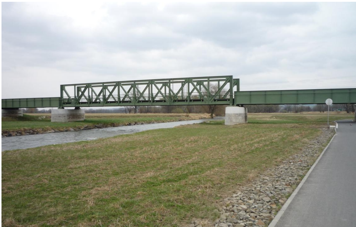
Obrázek 24 – Pohled na železniční most po proudu, km 34,403 (TPE 33,935)
