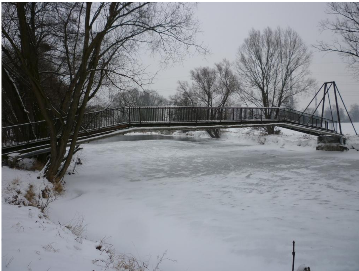
Obrázek 18 – Ocelová lávka pro pěší, pohled proti proudu km 32,789 (TPE 32,380)
