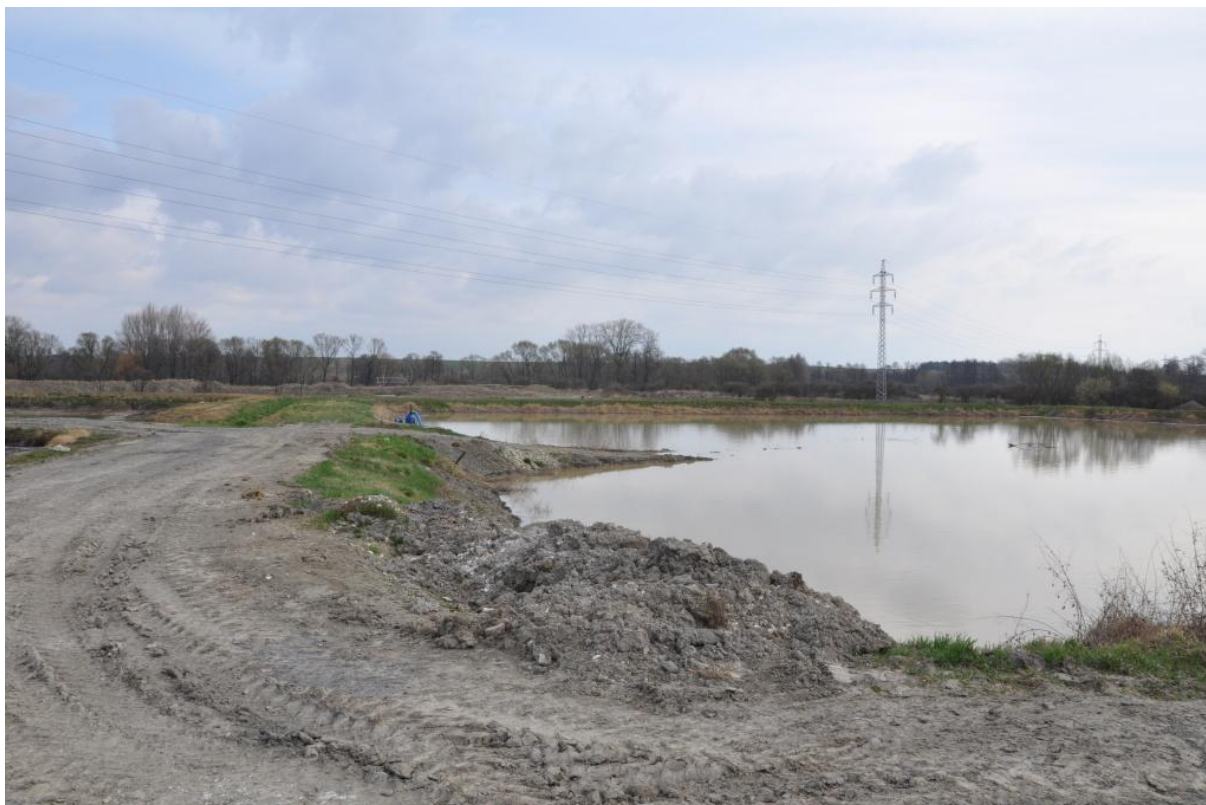
Obrázek 44 – Pohled na kalové pole z cukrovaru v pravém inundačním území, km 42,060
