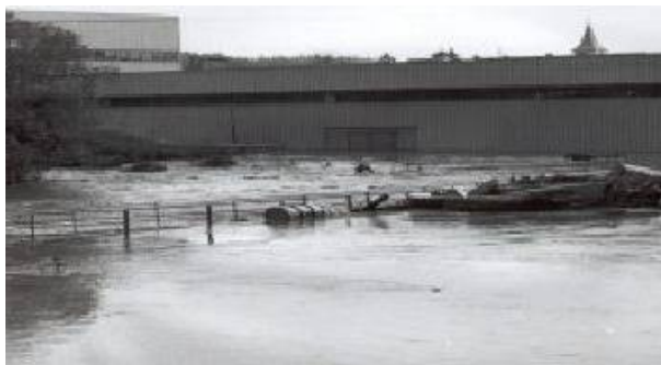
Obr. č. 3 Povodeň 1985 – průmyslový areál
