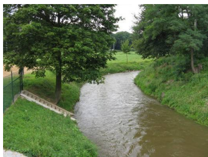
Koryto zatravněné, stromy a keře ojediněle Popřípadě svahy skalnaté, kamenité (svahy n = 0,045-0,055 )
