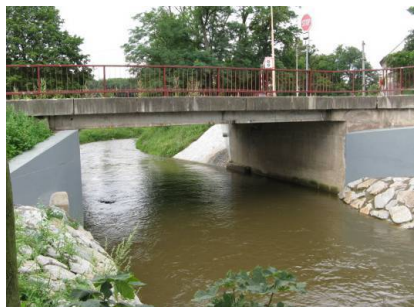
Koryto upravené, opevněné, bez křovin a stromů (svahy n = 0,04-0,045 )
