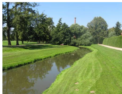
Koryto převážně zatravněné, sečené, stromy vně průtočného profilu (svahy n = 0,04 )
