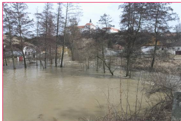
Obr. č. 3 Povodeň 2006 – podhrází VD Jevišovice
