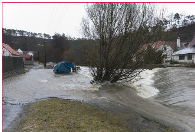
Obr. č. 2 Povodeň 2006 – pevný jez Jevišovice
