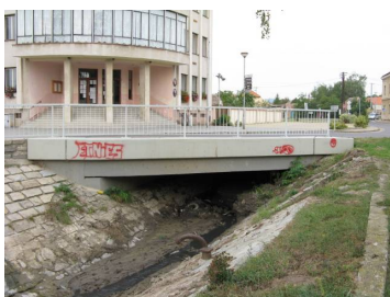
Obr. č. 5 Typické úseky pro rozdělení drsnosti: břehy holé, sem tam strom, úprava ve zdech, kamenná dlažba, rovinanina, zaklenutí, hráze
