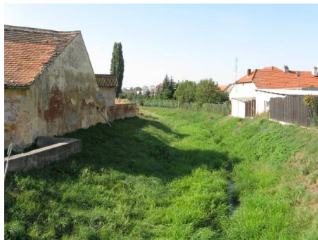
Obr. č. 3 Typické úseky pro rozdělení drsnosti: břehy holé, koryto zarostlé a zanešené - břehy holé, koryto zanešené, zástavba
