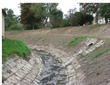
Obr. č. 5 Typické úseky pro rozdělení drsnosti: břehy holé, sem tam strom, úprava ve zdech, kamenná dlažba, rovinanina, zaklenutí, hráze
