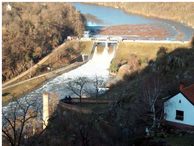
Obr. č. 5 Povodeň 2006 – VD Znojmo, naplavené kmeny
