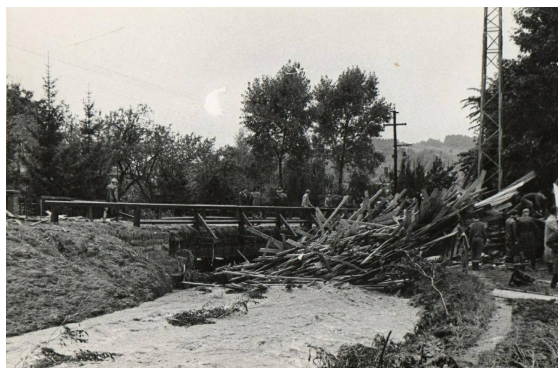
Obr. č. 9 Povodeň 1959 – Bojkovice
