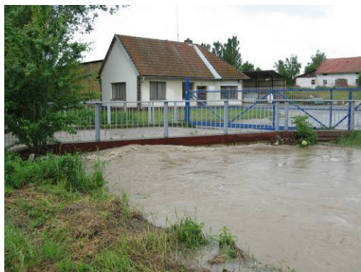
Obr. č. 15 Km 46,415 (TPE km 46,576) most Brankovice – kalibrace modelu – odpovídá Q 20
