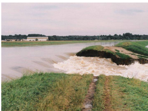
Obr. č. 5 Povodeň 1997 – protržená hrá v Lužici
