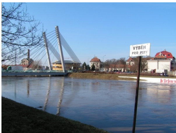
Obr. č. 4 Povodeň 2006 – silniční most Židlochovice
