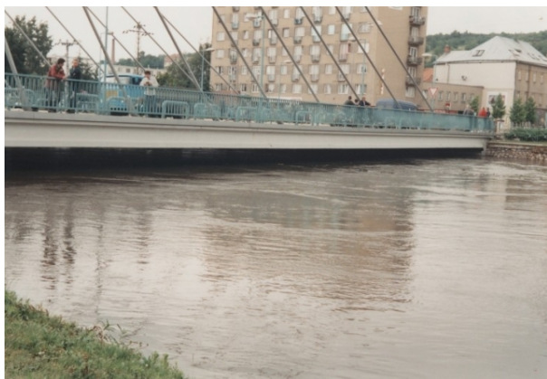
Obr. č. 2 Povodeň 1997 – silniční most Židlochovice
