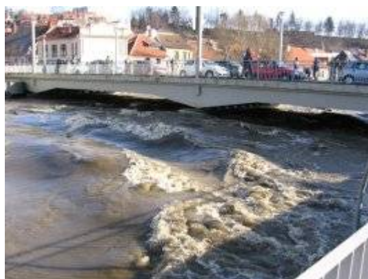
Obr. č. 5 Povodeň 2006 – silniční most v ul. 9.května
