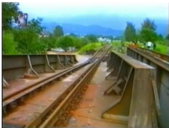
Obr. č. 8 Povodeň 1997 – železniční trať
