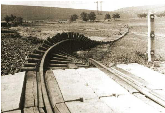
Obr. č. 3 Povodeň 1970 – zcela zdevastovaný úsek železniční trati Čejč – Ždánice u přejezdu silnice Kyjov Brno
