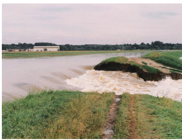
Obr. č. 6 Povodeň 1997 – protržená hrá v Lužici
