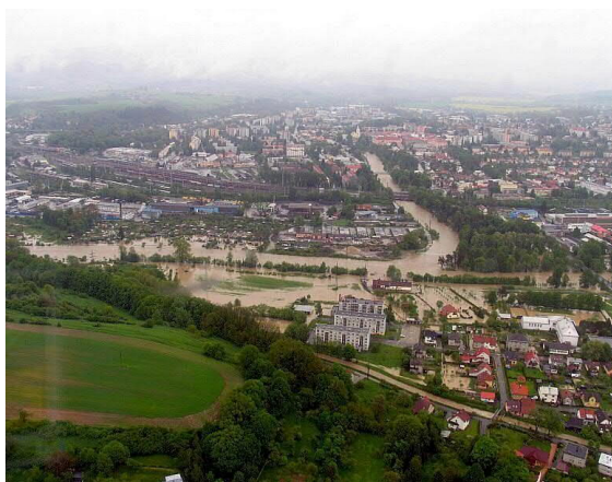
Obr. č. 13 Povodeň 1997 – Valašské Meziříčí
