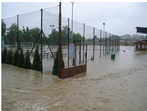
Obr. č. 5 Zatopené fotbalové hřiště
