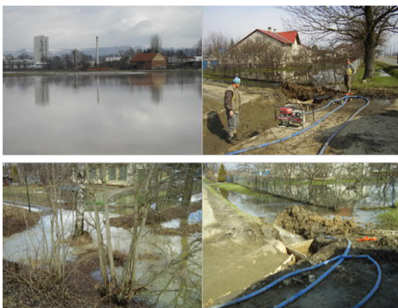
Obr. č. 7 Povodeň 2006 v Uničově
