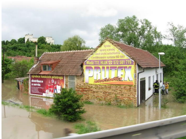
Obr. č. 7 Km cca 42,100 -42,300 LB inundace zaplavena
