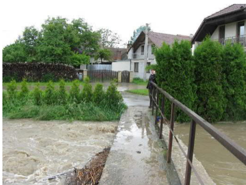
Obr. č. 5 Lávka v km 46,146, voda při kulminaci přetékala, na PB obtéká voda z Litensického p.
