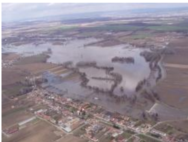
Obr. č. 5 Povodeň 2006 – Cvrčovice
