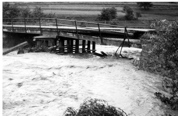
Obr. č. 4 Povodeň 1939 – Vizovice, most od Vsetína
