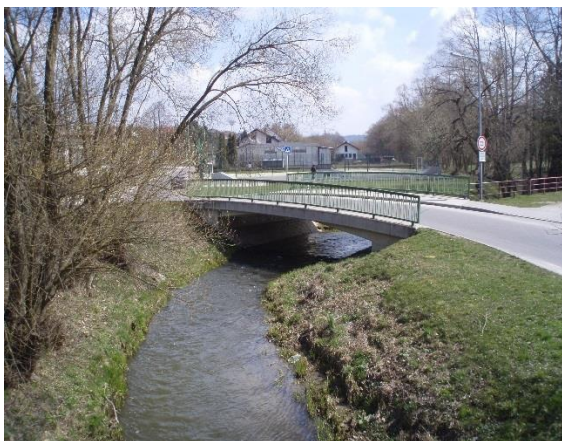
Obr. č. 11 Most přes Vápvku
