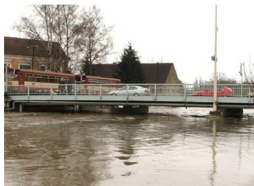
Obr. č. 4 Moravská Dyje v Dačicích, 29.3.2006
