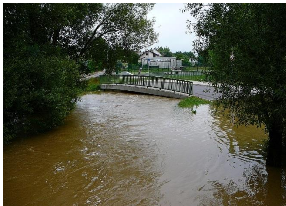
Obr. č. 12 Most přes Vápvku
