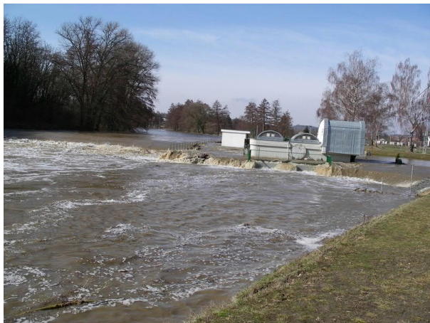
Obr. č. 3 Povodeň 2006 – MVE Na Réně
