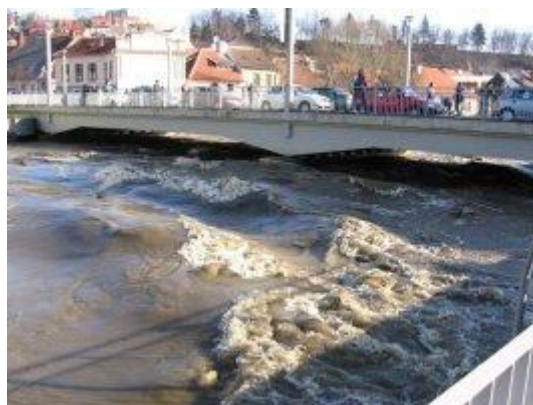
Obr. č. 7 Povodeň 2006 – silniční most v ul. 9.května
