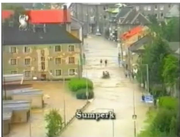
Obr. č. 8 Povodeň 1997 – Šumperk
