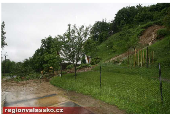
Obr. č. 9 Povodeň 2010 – Brumov-Bylnice, sesuv
